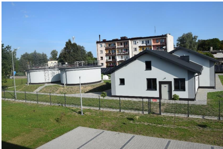
Zdjęcie – Stacja Uzdatniania Wody w Jabłonie Lackiej
