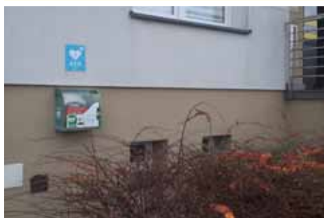
Urząd Gminy w Grodzisku Dolnym (na ścianie przy głównym wejściu)
