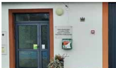
ŚDS w Podlesiu (na ścianie przy głównym wejściu)
