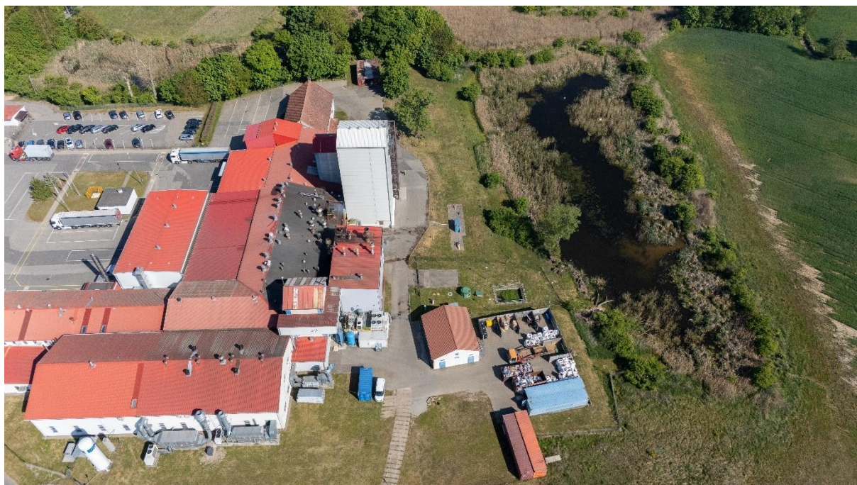
Fot. 1. Widok na wschodnią część zakładu wraz ze zbiornikiem wodnym.
