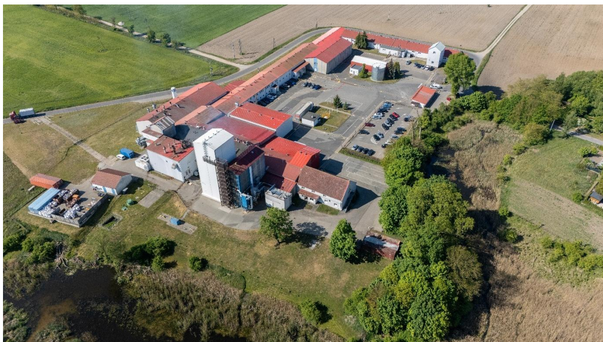
Fot. 2. Widok na teren zakładu od strony wschodniej.
