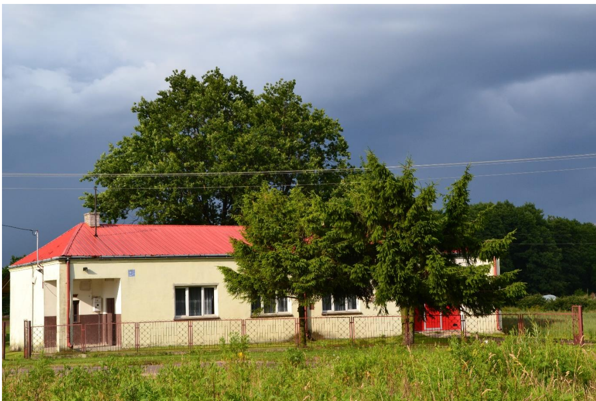
( Remiza OSP w Trzepowie – stan istniejący)
