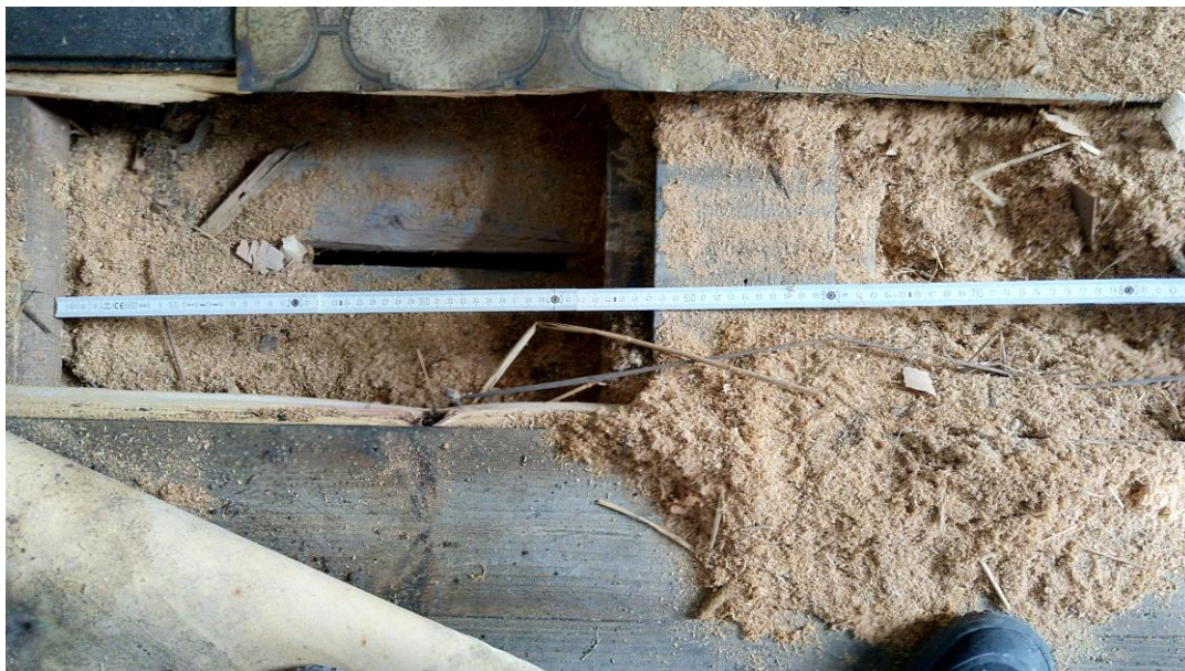
Rysunek 5. Konstrukcja stropu drewnianego
