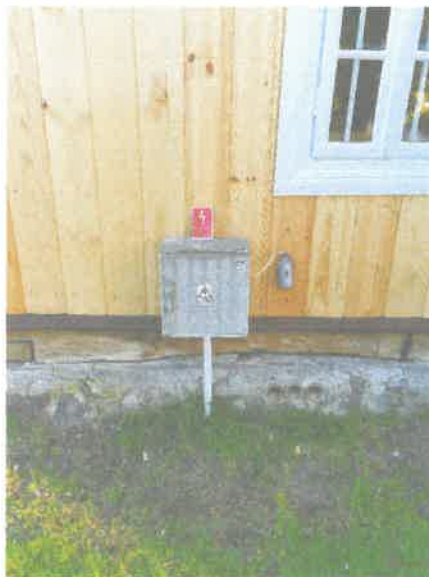
Fotografia nr 3 Lokalizacja przeciwpożarowego wyłącznika prądu
