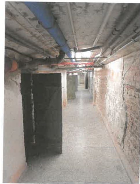
Widok instalacji technicznych powodujących obniżenia drogi ewakuacyjnej w kondygnacji podziemnej -1
