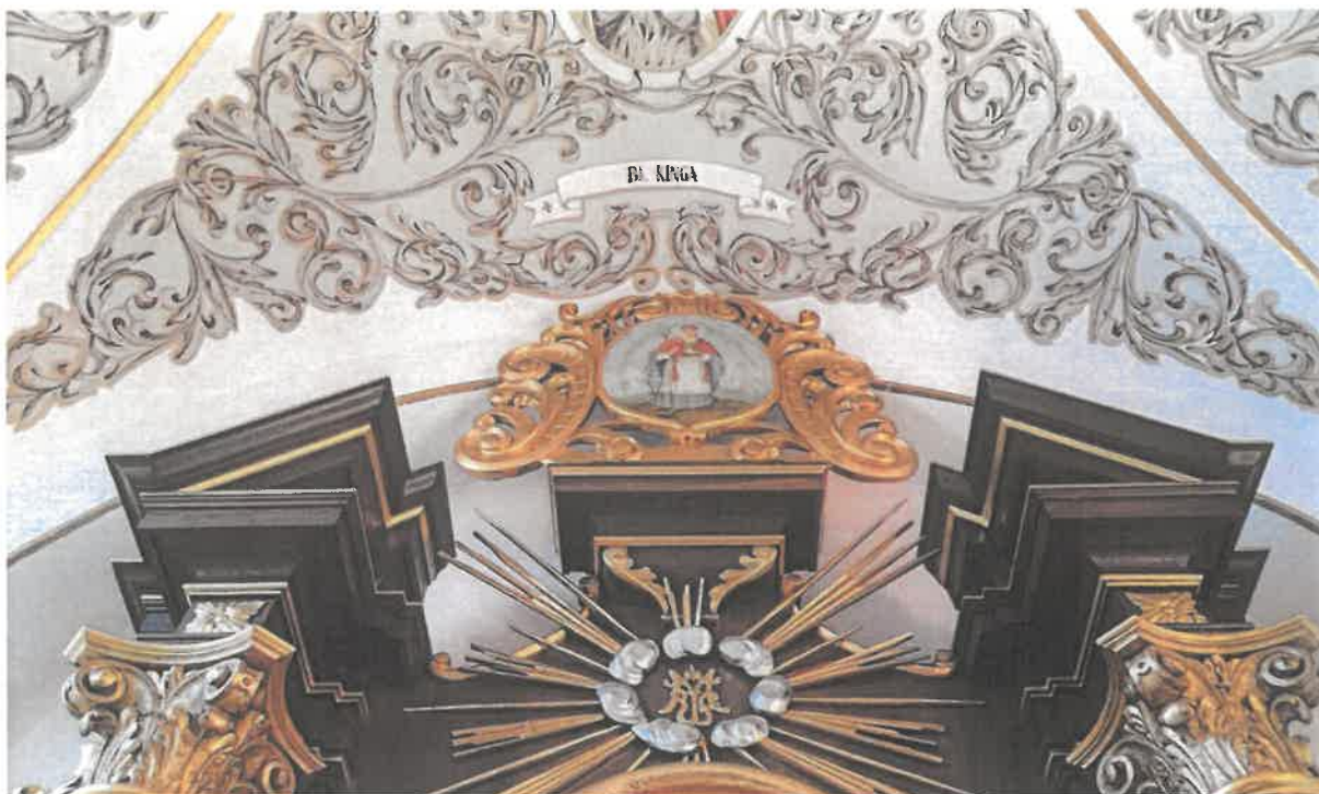
Fot.9 Zwieńczenie ołtarza św. Józefa. Detale wystroju snycerskiego oraz biel desek struktury zniszczone żerowaniem owadów. Pozłota zniszczona i skorodowana.
