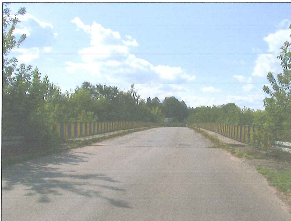
Fot. 3. Widok mostu z góry wraz z widokiem dojazdu od strony m. Podgórze.
