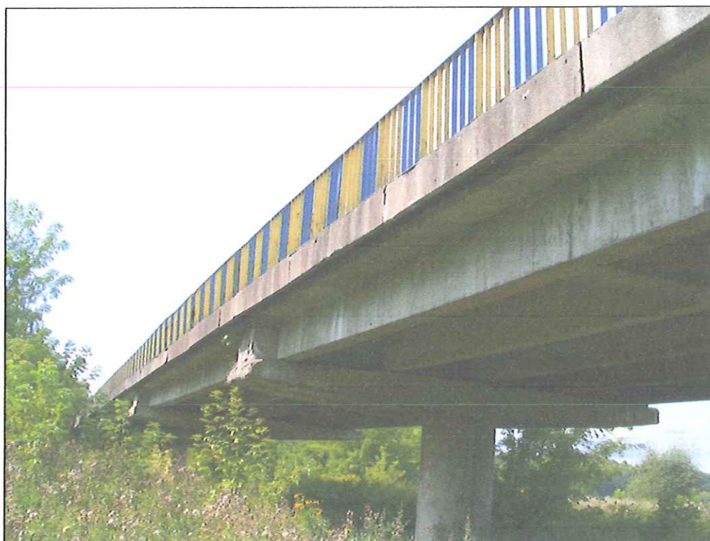
Fot. 1. Widok wzdłuż mostu od strony górnej wody (GW).
