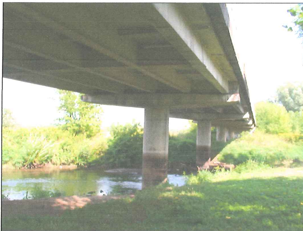
Fot. 4. Spód ustroju nośnego oraz podpór pośrednich - widok od strony m. Boria.
