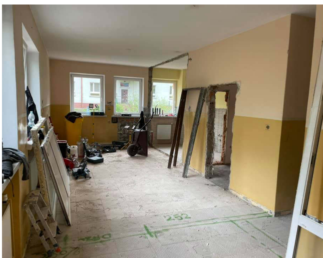
Prace budowlane w Klubie Seniora w Stryszowie już się rozpoczęły. Będzie to miejsce przyjazne dla osób starszych
