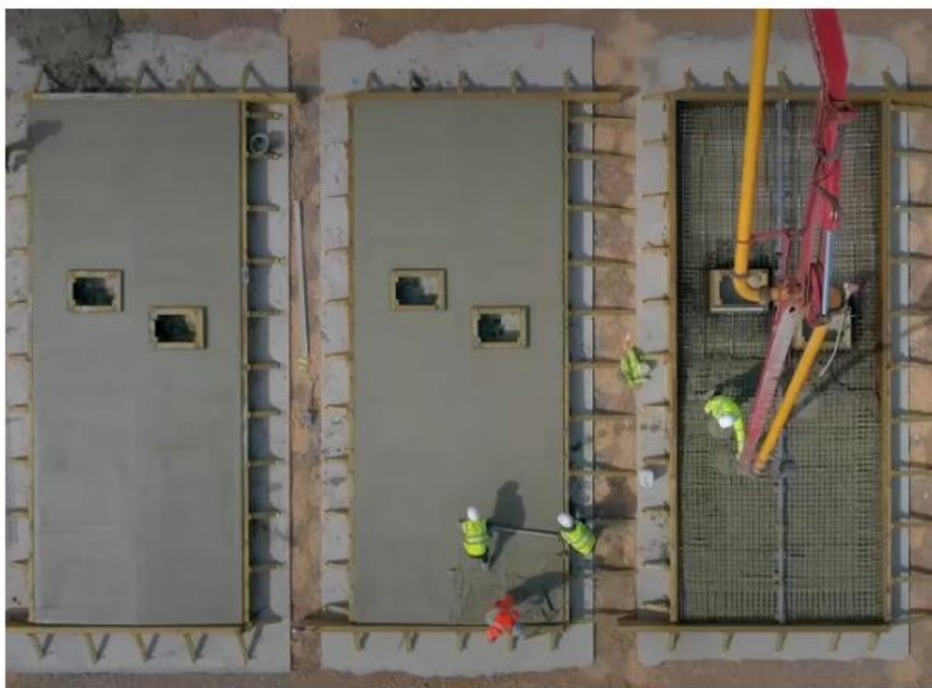
Ryc. 9. Prace realizacyjne - zbrojny fundament lany pod obiekty magazynów energii 5
