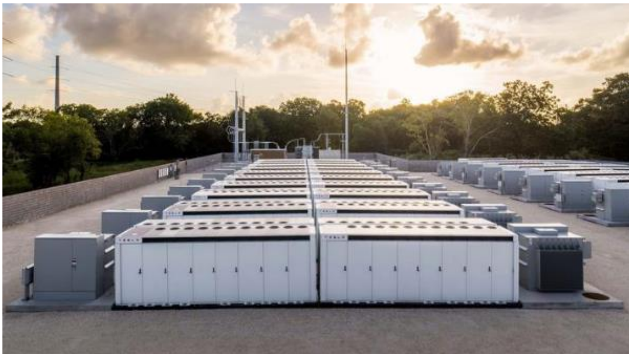
Ryc. 11. Układanie zestawów bateryjnych na płytach fundamentowych zbrojonych 7
