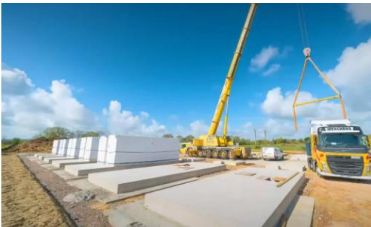
Ryc. 10. Układanie zestawów bateryjnych na płytach fundamentowych zbrojnych 6
