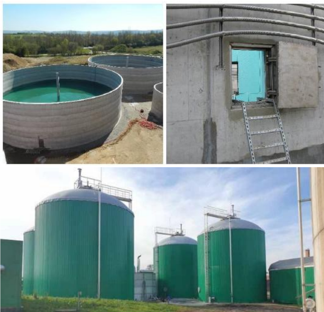
Rys. 3d. Żelbetowy zbiorniki nieuzbrojone w trakcie budowy (rysunek z lewej u góry); włącz technologiczny z systemem grzewczym zbiornika fermentacyjnego żelbetowego (rysunek z prawej u góry), zbiorniki fermentacyjne stalowe wysokie (rysunek na dole) .
