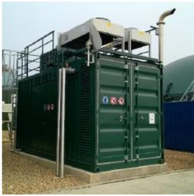
Rys. 3h. Jedna jednostka kogeneracji
