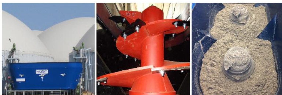
Rys. 3a. System dozowania sypkich substratów.
