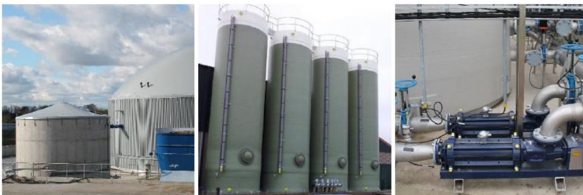
Rys. 3c. Zbiornik na płynne substraty żelbetowy ten mniejszy (rysunek z lewej); zbiorniki magazynowe z tworzywa sztucznego na inne płynne substraty z kručami przyłączenia na pojazdy dowożące substraty płynne (rysunek środkowy); pompy (rysunek z prawej).
