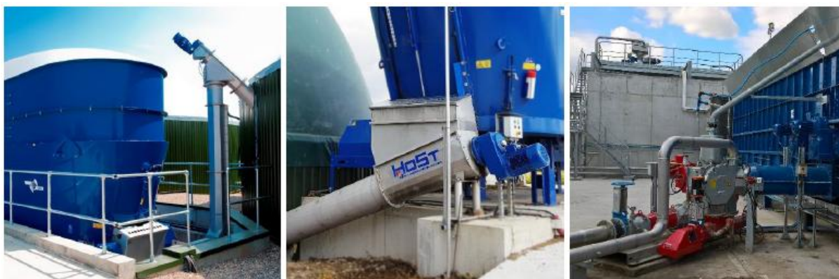
Rys. 3b. Integracja zasobnika substratów sypkich z komorą fermentacyjną.
