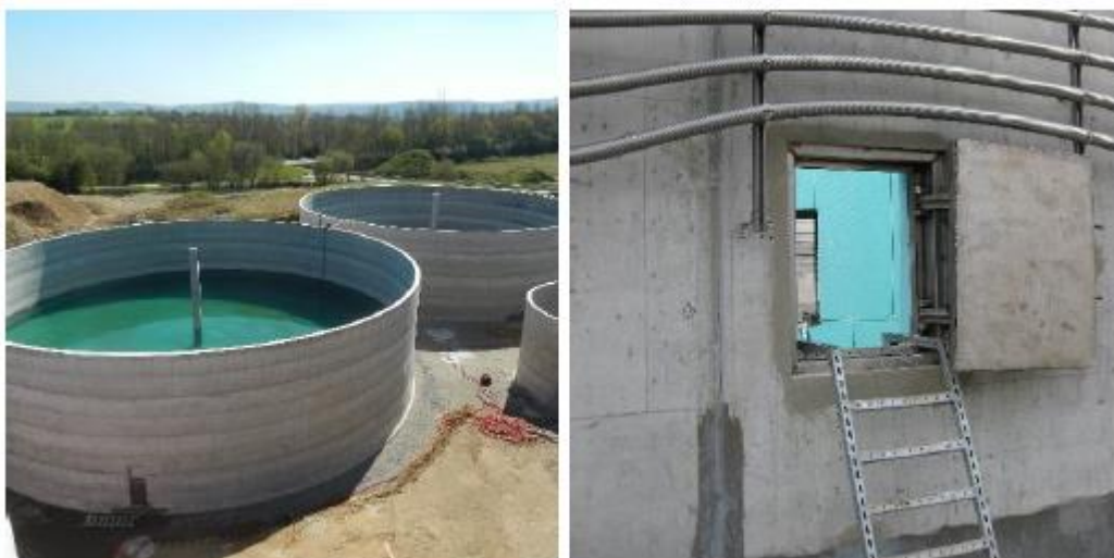
Rys. 3d. Żelbetowy zbiorniki nieuzbrojone w trakcie budowy (rysunek z lewej); włącz technologiczny z systemem grzewczym zbiornika fermentacyjnego żelbetowego (rysunek z prawej).
