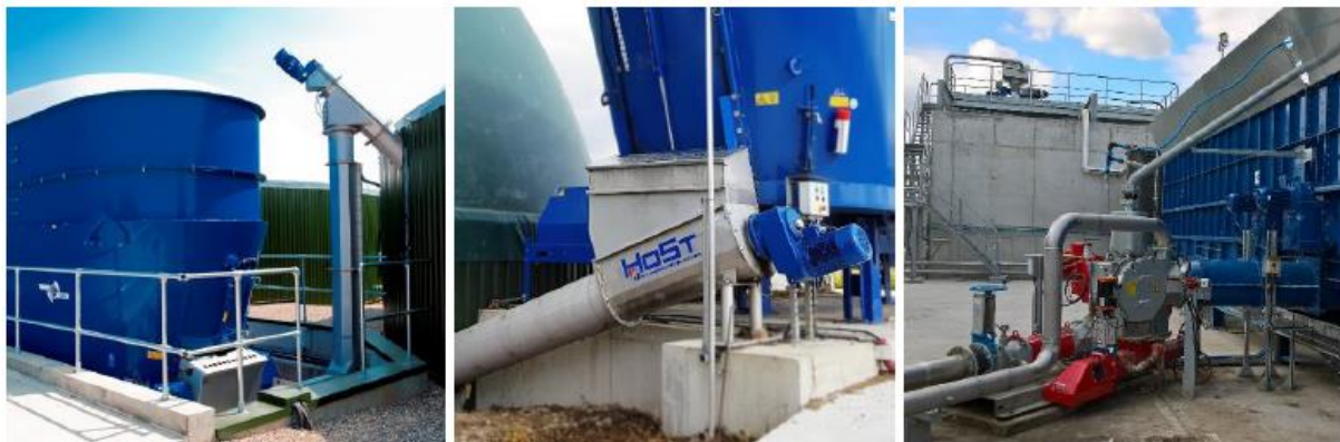
Rys. 3b. Integracja zasobnika substratów sypek z komorą fermentacyjną.
