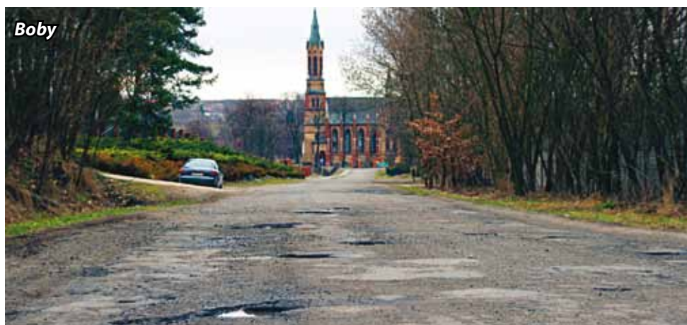
Skrzyżowanie w Popkowicach zostanie przebudowane.
