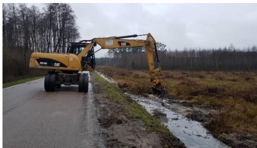
Fot. 31 Prace nad odtwarzaniem, odmulaniem i wykoszeniem rowów przydrożnych
