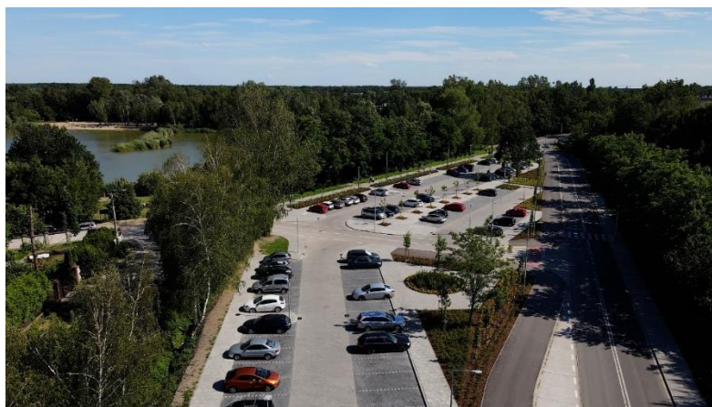
Fot. 32 Parking przy Gliniankach wybudowany w ramach modernizacji ul. Lipowej i Wolności w Zielonce
