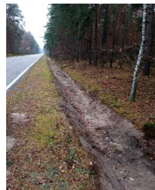
Fot. 31 Prace nad odtwarzaniem, odmulaniem i wykoszeniem rowów przydrożnych
