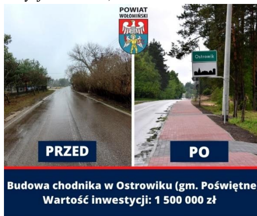
Fot. 35 Budowa chodnika w Ostrowiku
