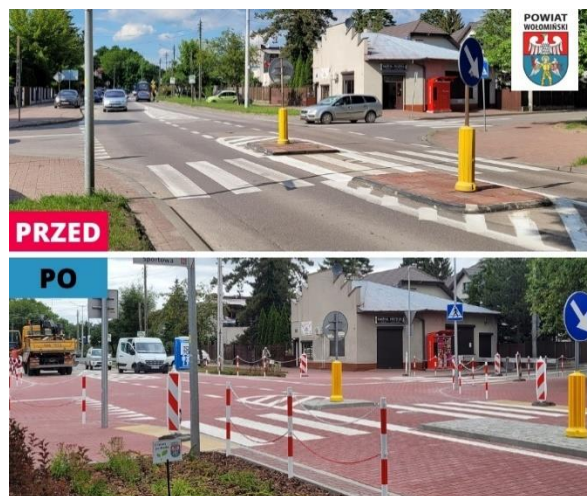
Fot. 42 Wyniesione skrzyżowanie na ul. Fiedorfa w Wołominie
