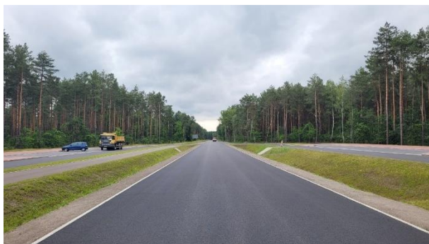
Fot. 34 Rozbudowa drogi powiatowej w msc. Zabraniec
