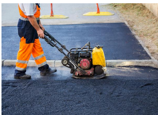
Fot. 39 Zagęszczarka na potrzeby Wydziału Dróg Powiatowych
