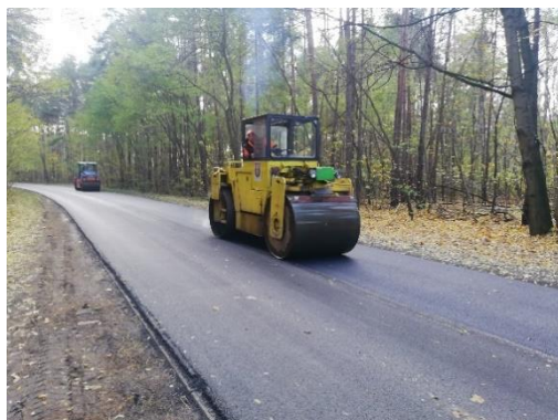
Fot. 30 Nowe nakładki bitumiczne
