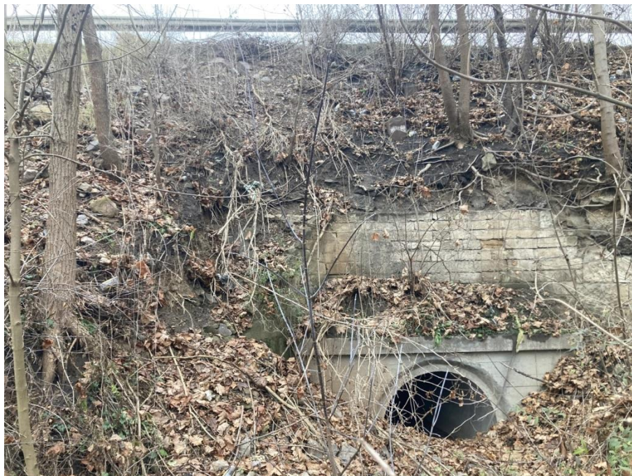
Foto 3, 4. Widok na wylot przepustu od strony południowej.
