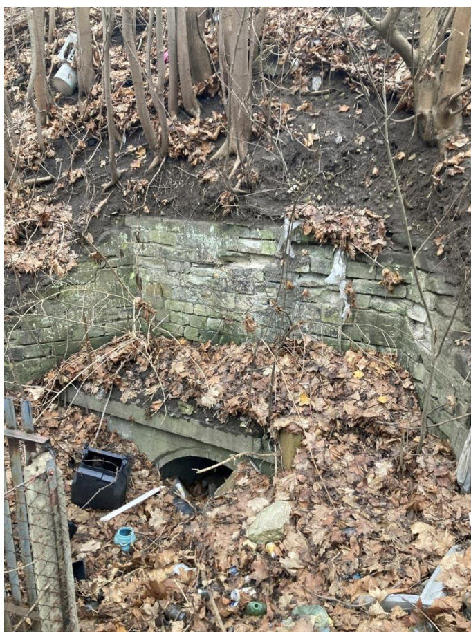
Foto 1, 2. Widok na wlot przepustu od strony północnej.
