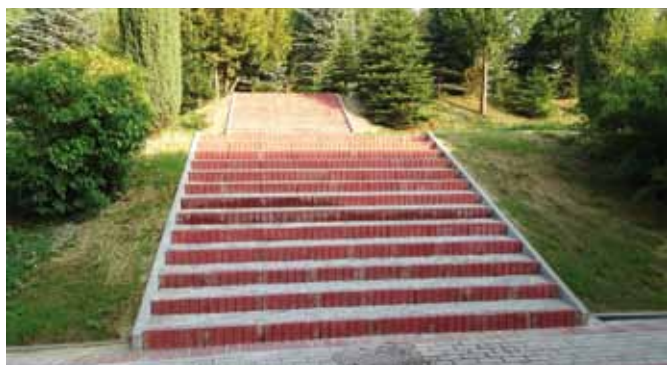
Odnowione schody przy SP w Lubeni
