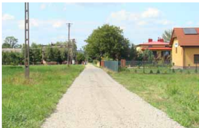
Droga wewnętrzna Siedliska – Rzeki
