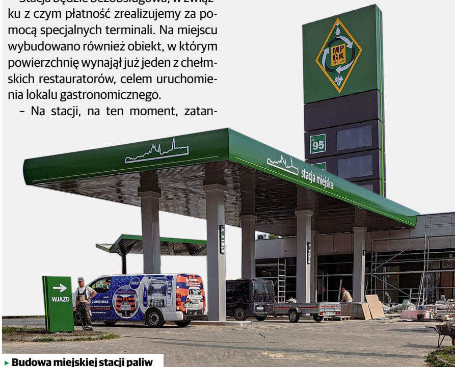
► Budowa miejskiej stacji paliw
