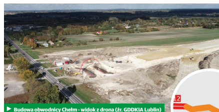
► Budowa obwodnicy Chełm - widok z drona (źr. GDDKiA Lublin)
