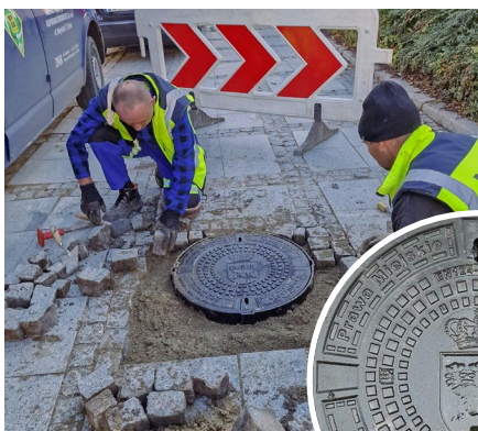
► Montaż nowych włazów
