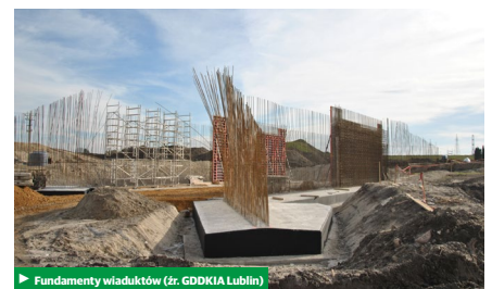
► Fundamenty wiaduktów (źr. GDDKiA Lublin)
