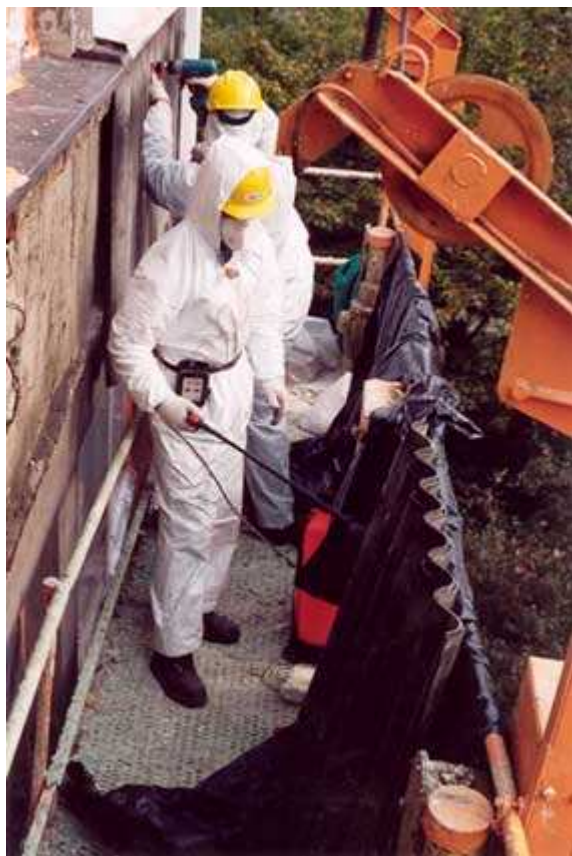
Fot. 1 - 5 Usuwanie wyrobów azbestowych
