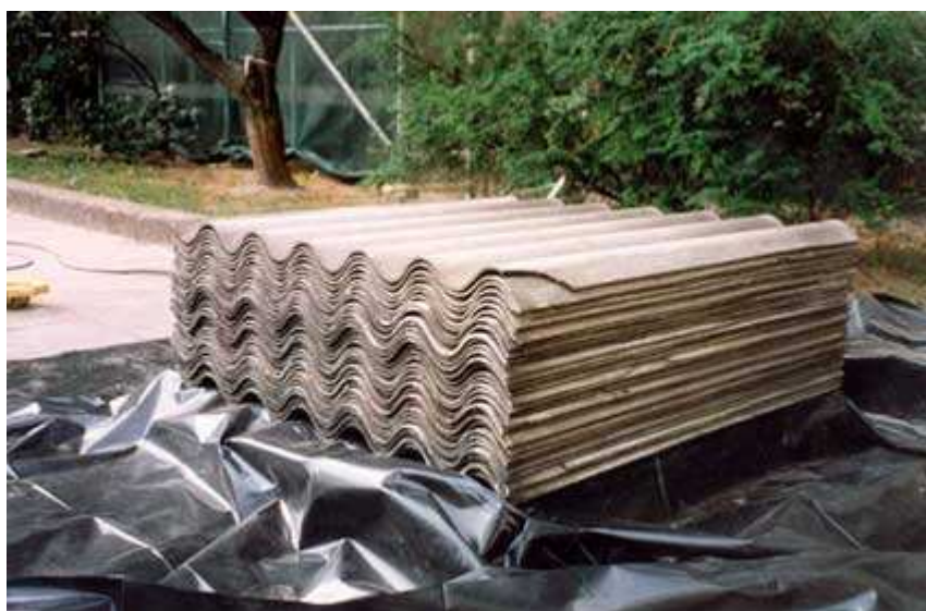
Fot. 6 – 8 Przygotowanie wyrobów azbestowych do transportu
