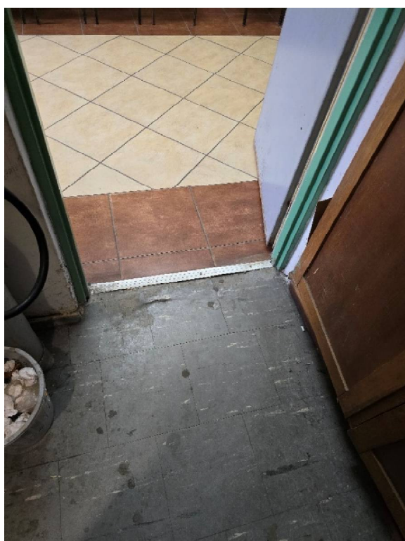
Podłoga w magazynku
