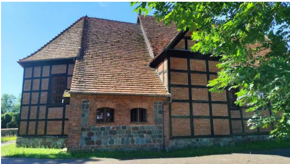
Widok elewacji bocznej północnej.
