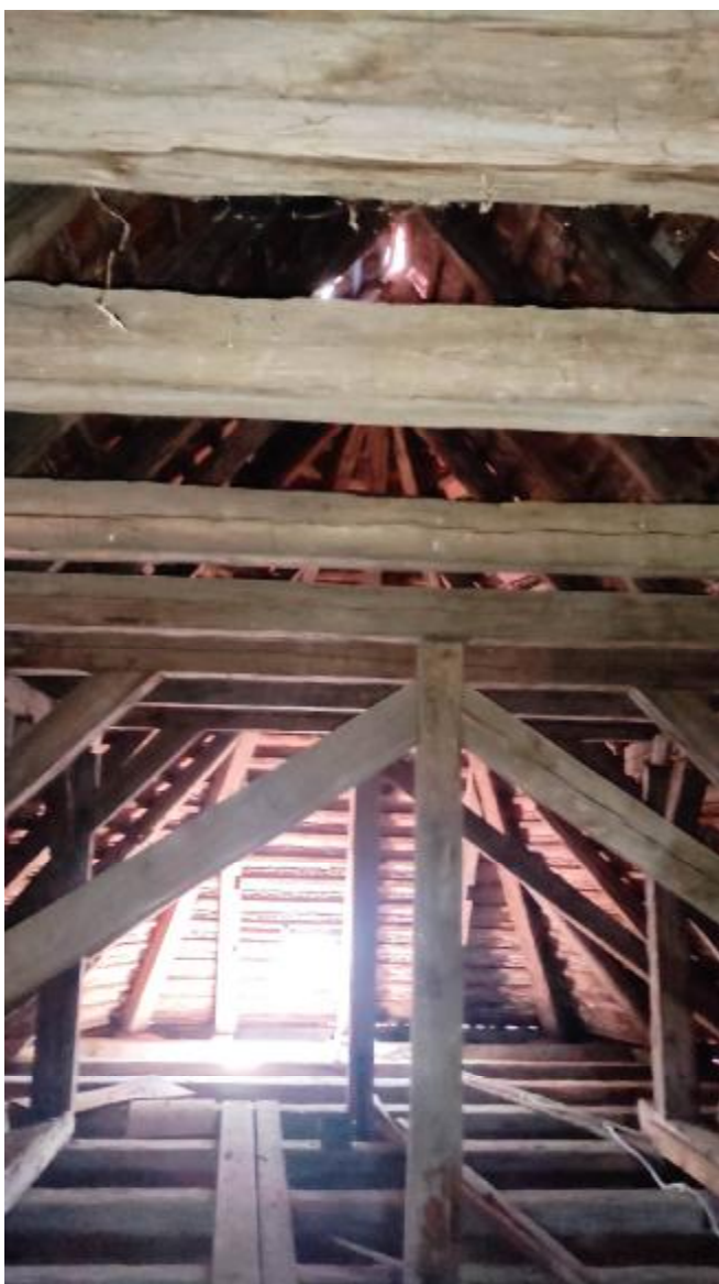
Widok na konstrukcję dachu nad absydą i prezbiterium.
