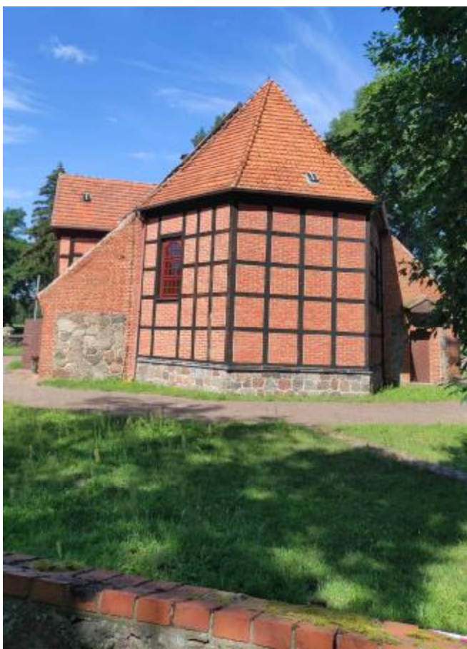
Widok elewacji tylnej wschodniej
