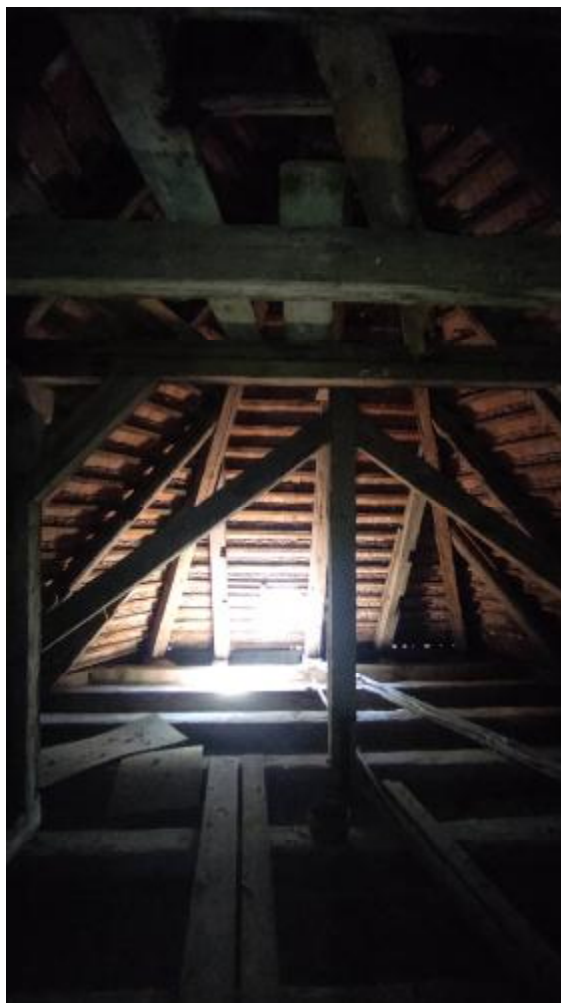
Widok na konstrukcję dachu nad absydą.
