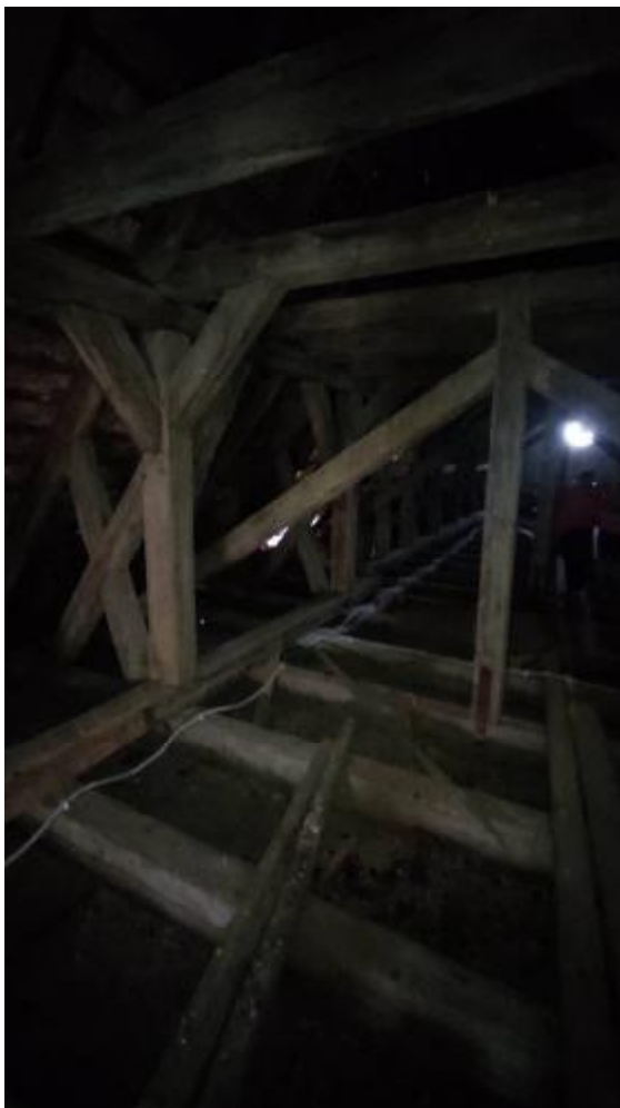
Widok na konstrukcję dachu (w kierunku nawy głównej)
