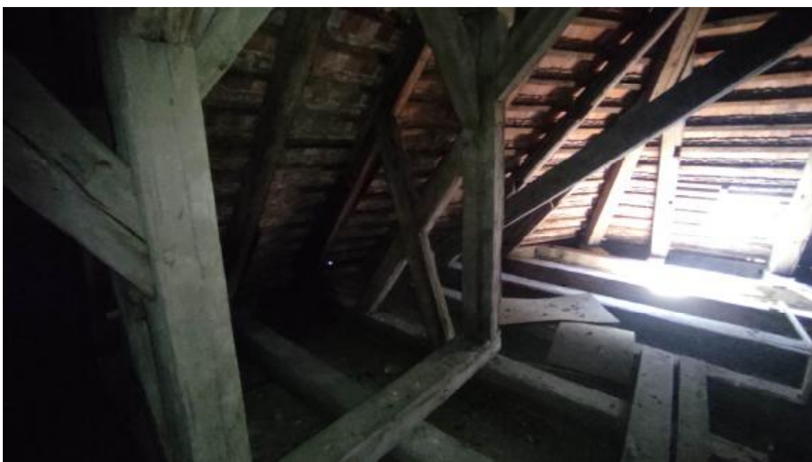
Widok na konstrukcję dachu nad absydą i prezbiterium.
