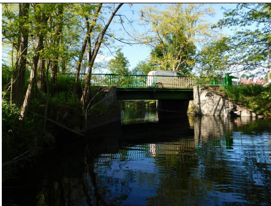
Fot.6. Widok ogólna na obiekt. Widok od strony południowej.
