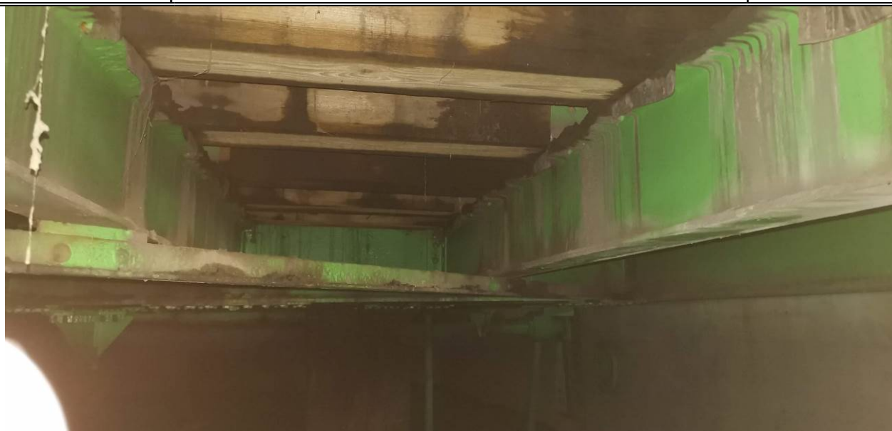
Fot.5. Widok na dolną powierzchnię przęsła. Przęsło nad schronem.
