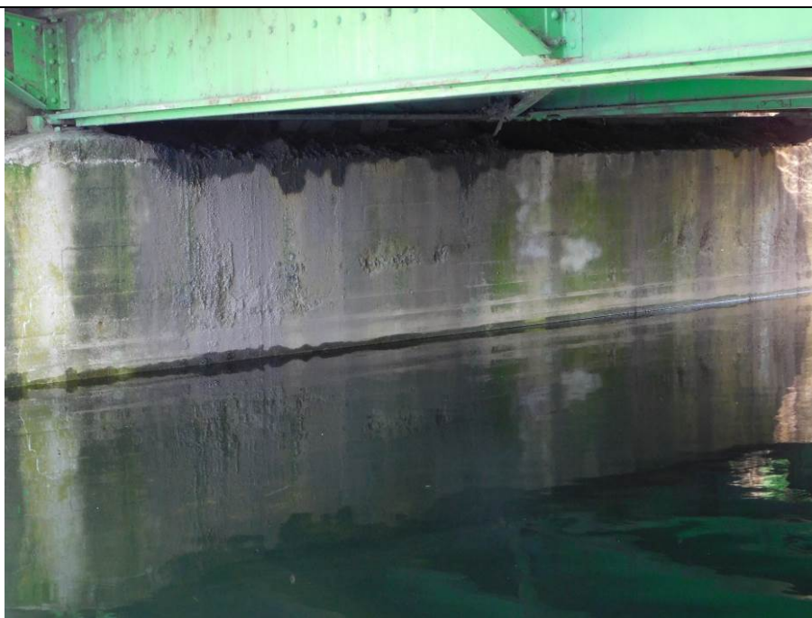
Fot. 2. Widok ogólna na przyczółek. Podpora od strony w. Łąkie
