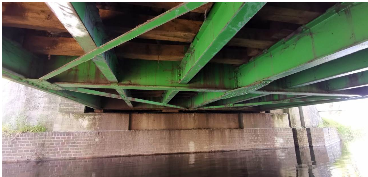
Fot.4. Widok na dolną powierzchnię przęsła. Przęsło nad korytem kanału Ołobickiego.
