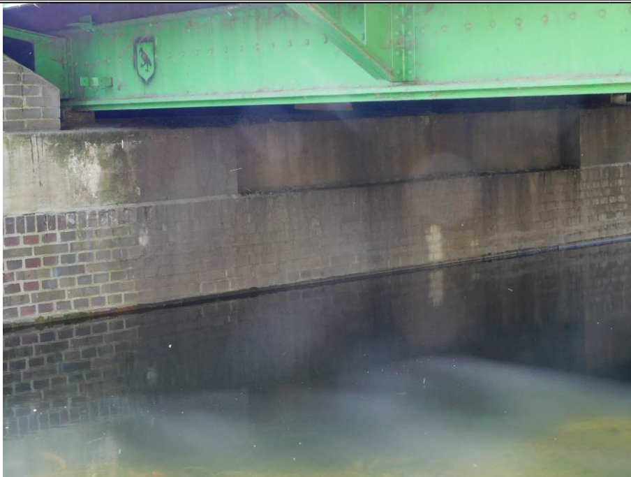
Fot.3. Widok ogólna na filar. Widok od strony przęsła nurtowego.
