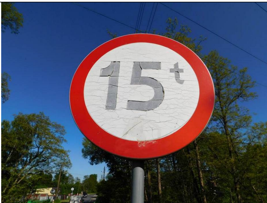
Fot.18. Widok na znak pionowy od strony Niesulic. Widoczna delaminacja powłok.
