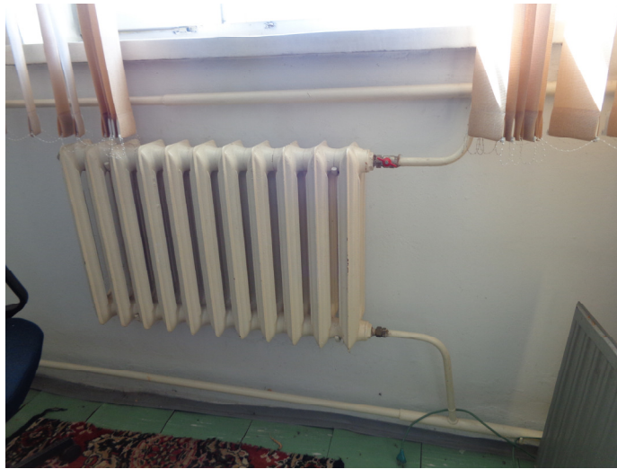
Grzejnik do przeniesienia na sąsiednią ścianę
