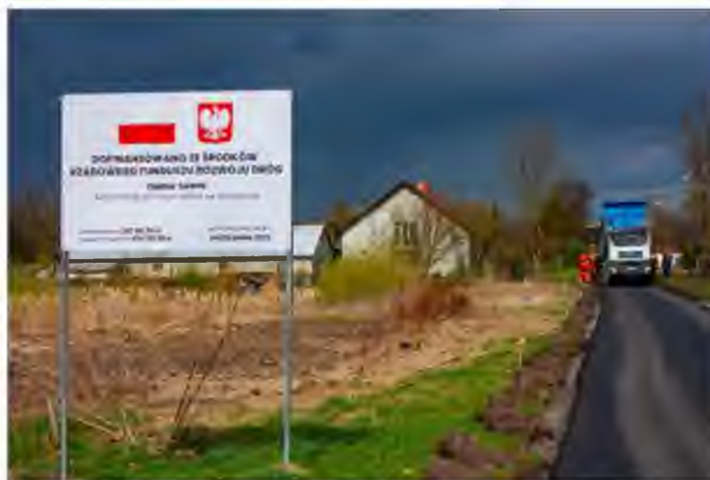
Ryc. 38 Remont drogi w Sajczycach.
