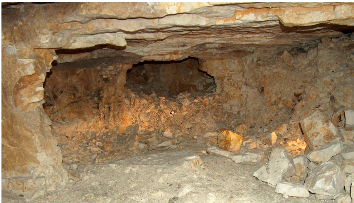
Wnętrze wyrobiska górniczego typu filarowo-komorowego w Krzemionkach
