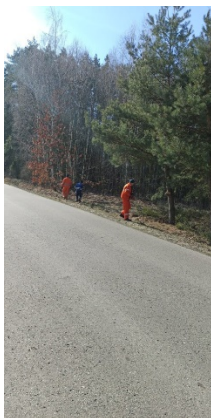
Wycinka ręczna krzewów i gałęzi drzew przez pracowników Zarządu Dróg Powiatowych w Makowie Mazowieckim w ramach bieżącego utrzymania dróg powiatowych
