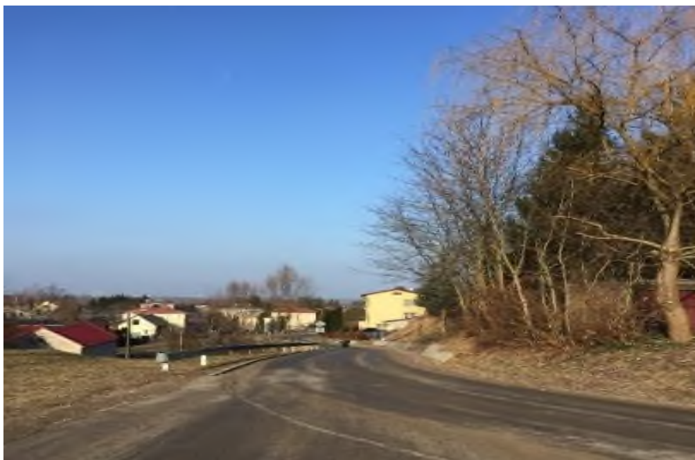
Zdjęcie 11 Zmodernizowane odcinki dróg w msc. Goździelin oraz Garbacz
