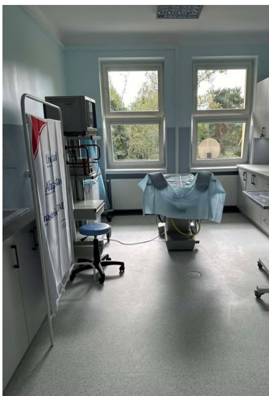
Remont Oddziału Urologicznego
