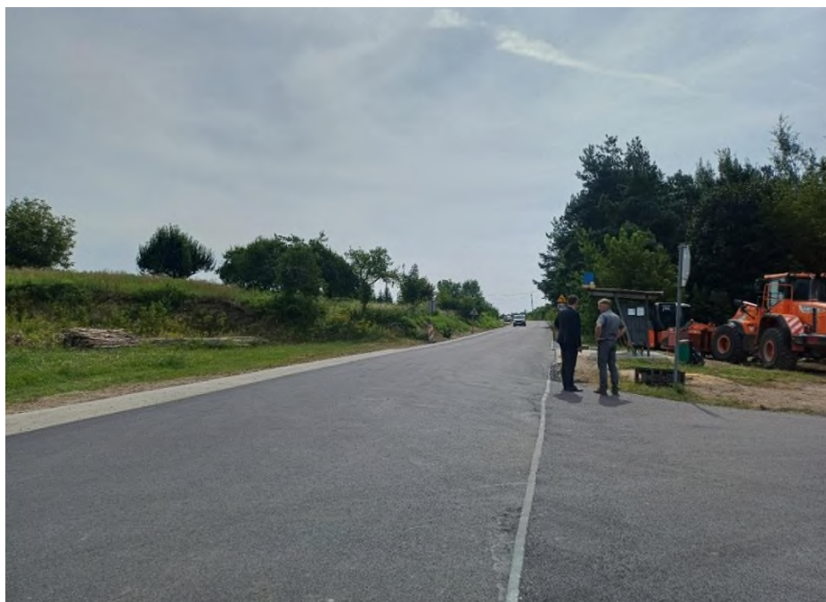
Zdjęcie 17 Remont drogi powiatowej w msc. Podgórze i Wiktoryn.
