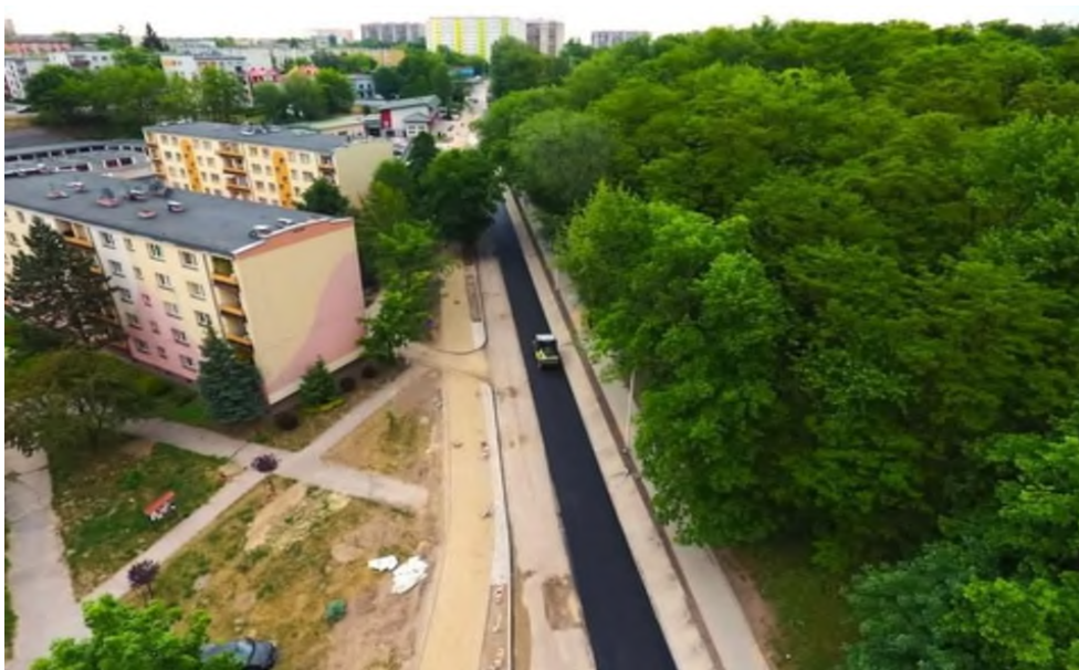
Zdjęcie 19 Wyremontowany odcinek ul. Mickiewicza w Ostrowcu Świętokrzyskim.
