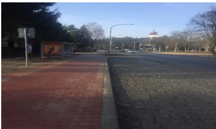
Zdjęcie 15 Przebudowany odcinek drogi powiatowej Ostrowiec Świętokrzyski-Boksycka.
