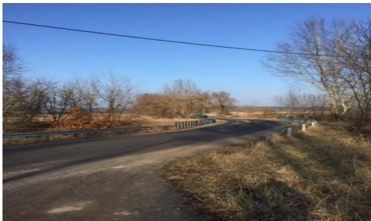
Zdjęcie 16 Wyremontowany odcinek drogi powiatowej Ostrowiec Świętokrzyski-Przyborów-Bodzechów.
