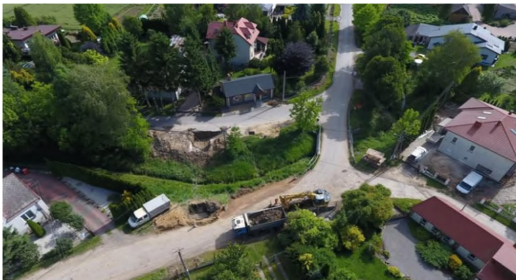
Zdjęcie 10 Rozbudowa drogi powiatowej w msc. Świrna.
