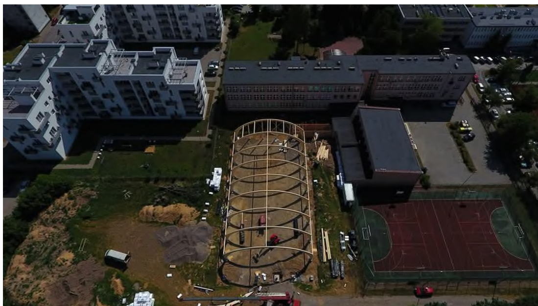
Zdjęcie 6 Budowa boiska wielofunkcyjnego.
