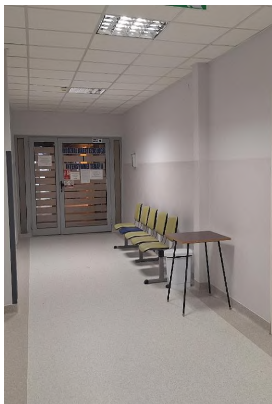
Remont korytarza na parterze bloku C
