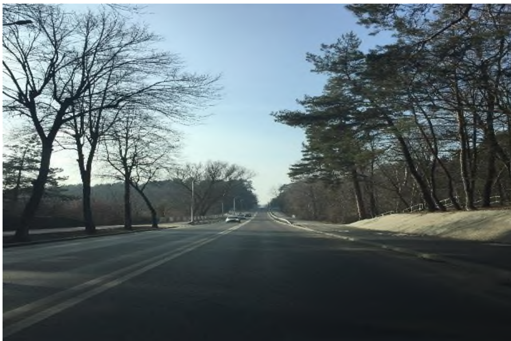
Zdjęcie 9 Przebudowany odcinek drogi powiatowej Ostrowiec Świętokrzyski-Boksycka.
