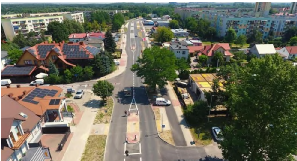
Zdjęcie 13 Wyremontowany odcinek ul. 11 Listopada w Ostrowcu Świętokrzyskim.
