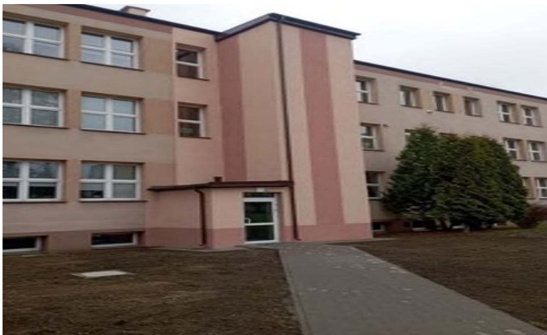
Zdjęcie 4 Nowo wybudowana winda przy LO Nr II.
