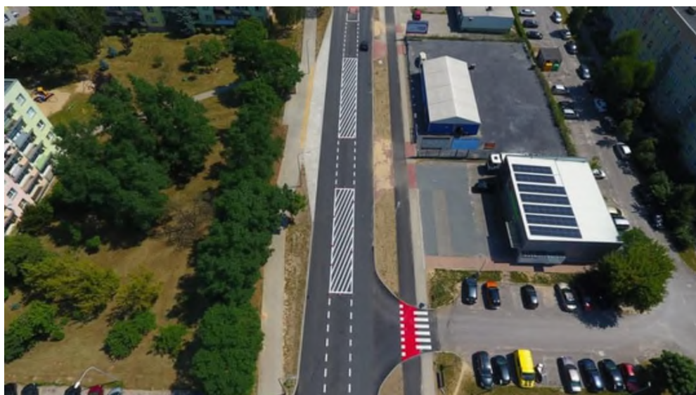
Zdjęcie 14 Wyremontowany odcinek ul. 11 Listopada w Ostrowcu Świętokrzyskim.
