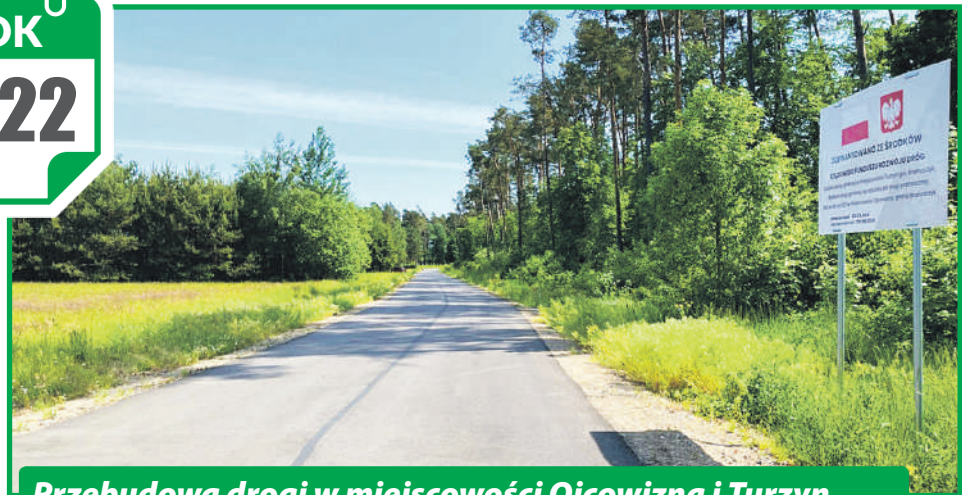
Przebudowa drogi w miejscowości Ojcowizna i Turzyn
