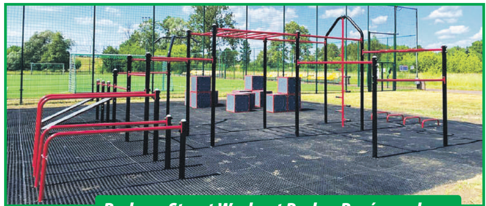
Budowa Street Workout Park w Brańszczyku
