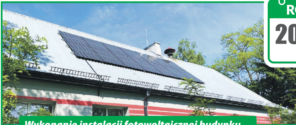
Wykonanie instalacji fotowoltaicznej budynku OSP Udrzyn
