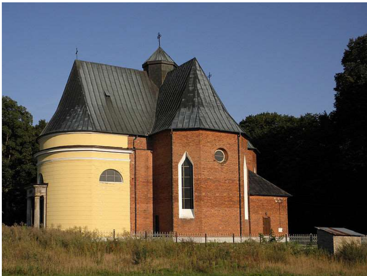
Widok od strony zachodniej (rys. 13) po lewej stronie dawna kaplica, po prawej nowa kaplica oraz zakrystia.
