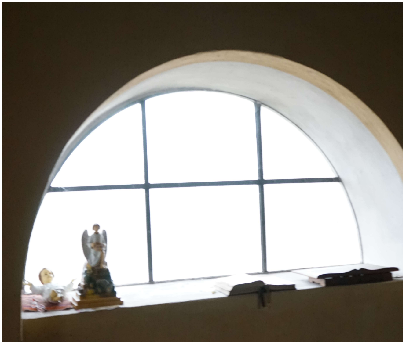
Na chórze stałe półkoliste żeliwne okna bez witraży (Rys.26).
