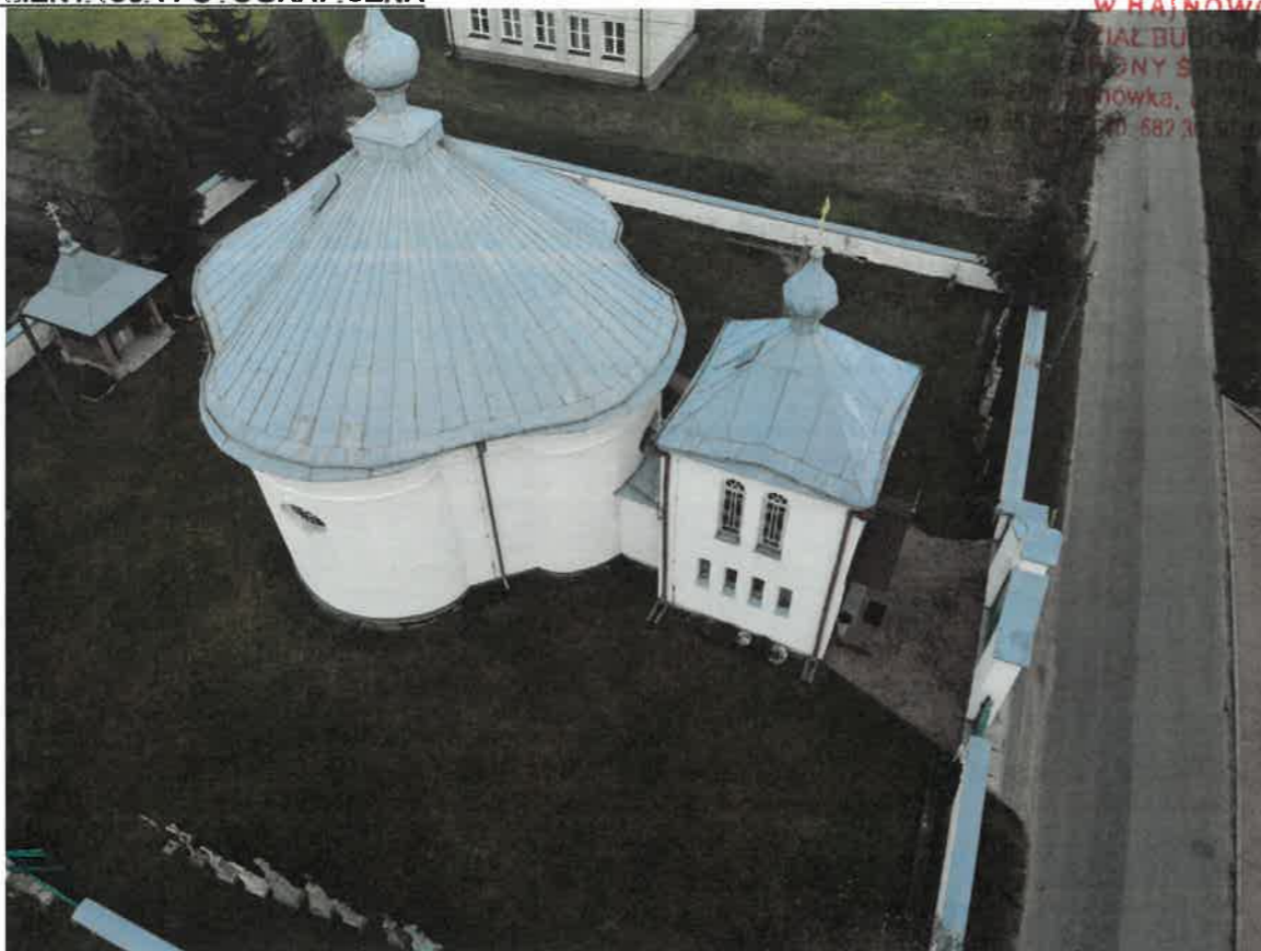
Zdj.1 Widok dachu z góry
