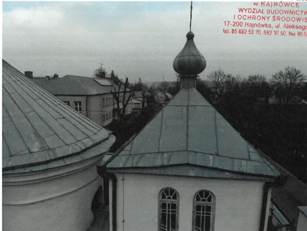
Zdj. 5 Zadaszenie wieży
