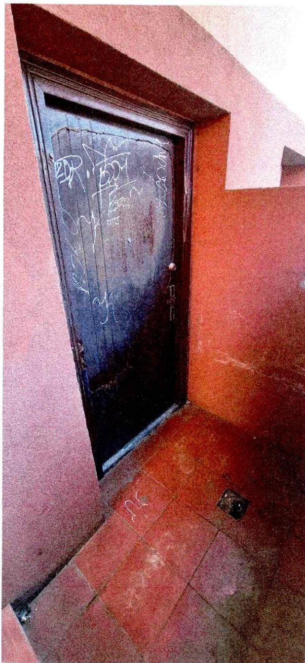
Fot. 18. Widok na podest dolny schodów zejścia do piwnicy
