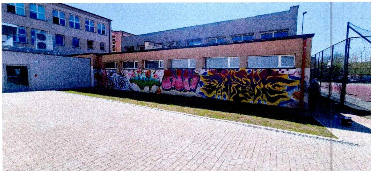
Fot.33. Sala gimnastyczna z zapleczem- elewacja północna
