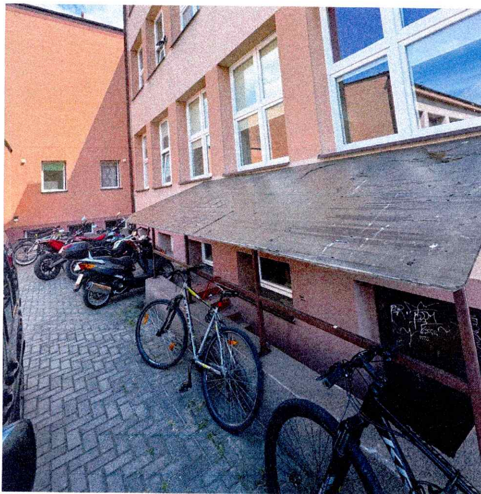
Fot. 9. Widok na zadaszenie nad wejściem do piwnicy
