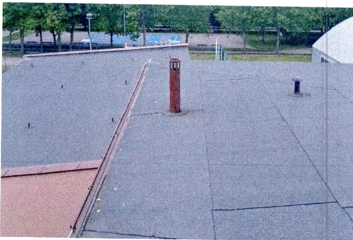
Fot. 7. Widok na dach - kominki kanalizacji sanitarnej
