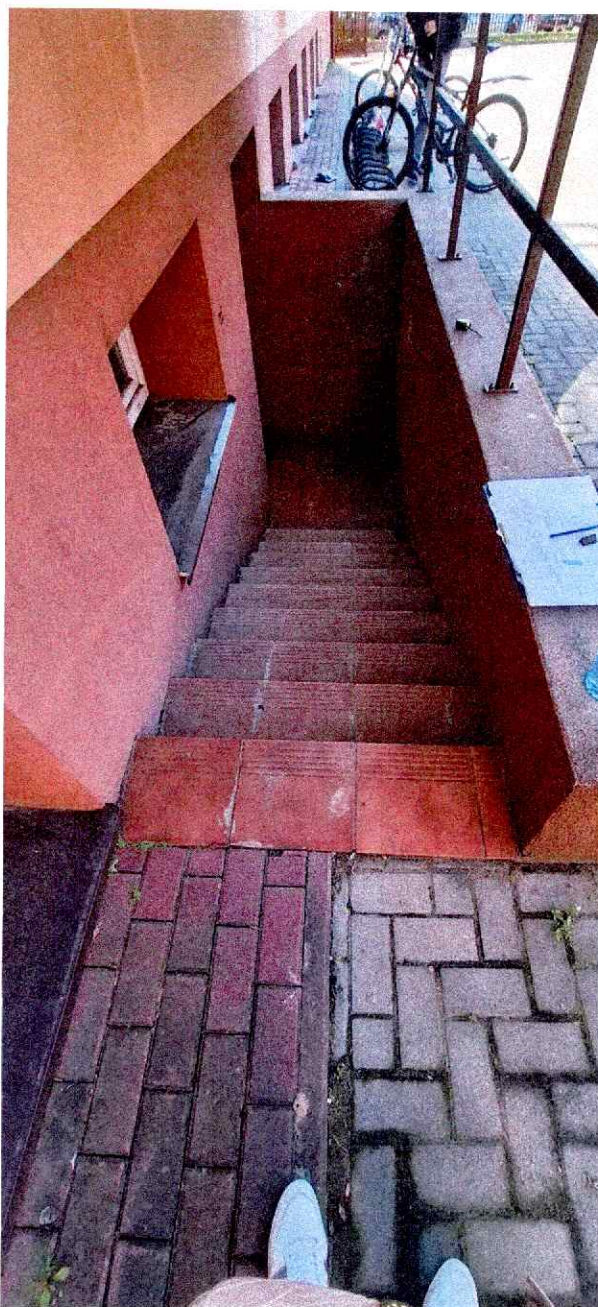
Fot. 17. Widok na schody zejścia do piwnicy
