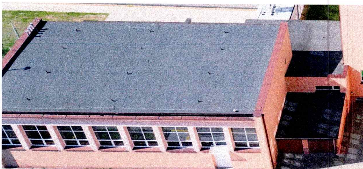
Fot.40. Widok na dach nad salą gimnastyczną
