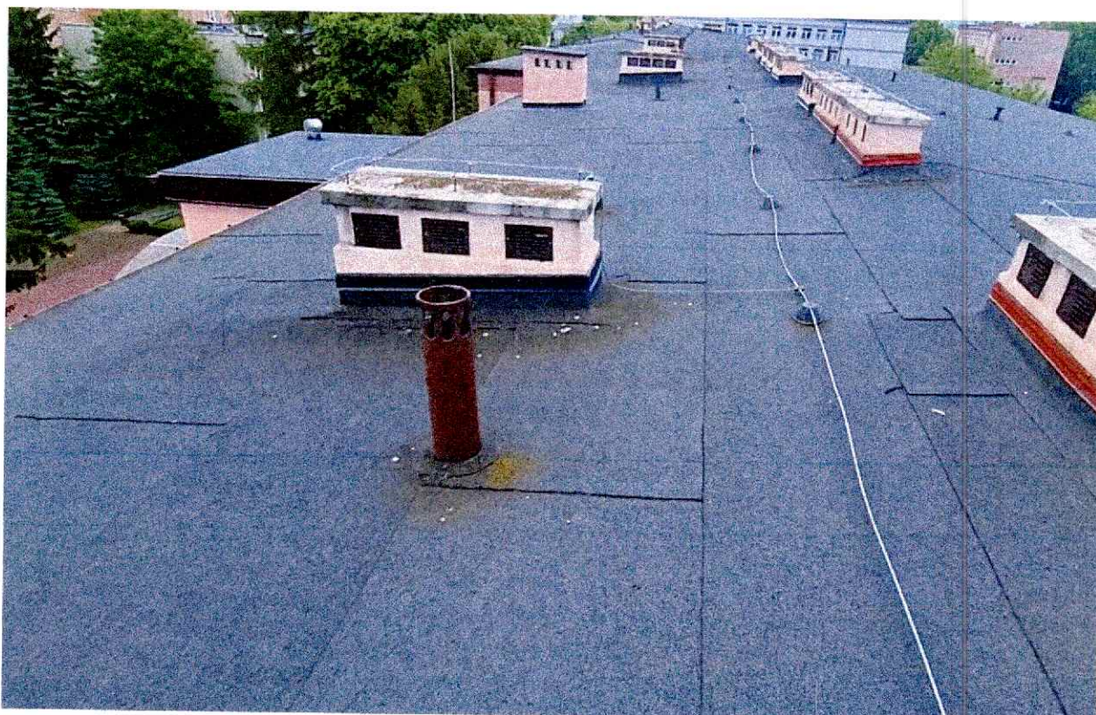
Fot. 7. Widok na dach - kominki kanalizacji sanitarnej
