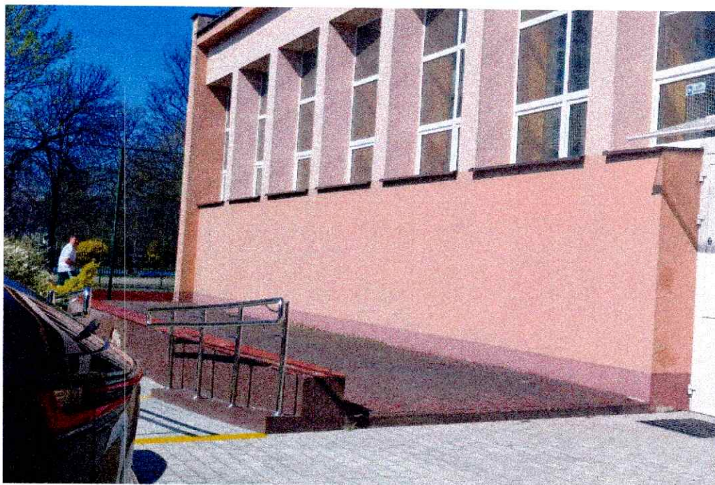
Fot. 21. Widok na murek wzdłuż sali gimnastycznej
