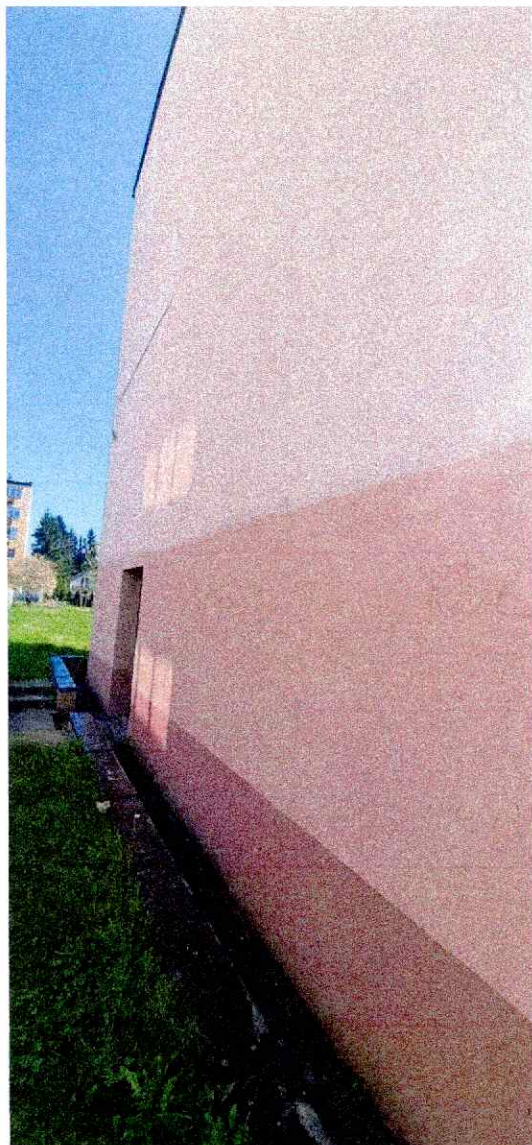
Fot.28. Widok na elewację północną
