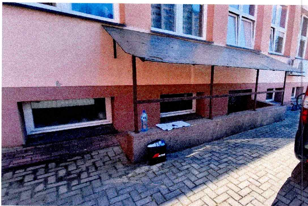
Fot. 19. Widok na murki oporowe przy zejściu do piwnicy od strony parkingu
