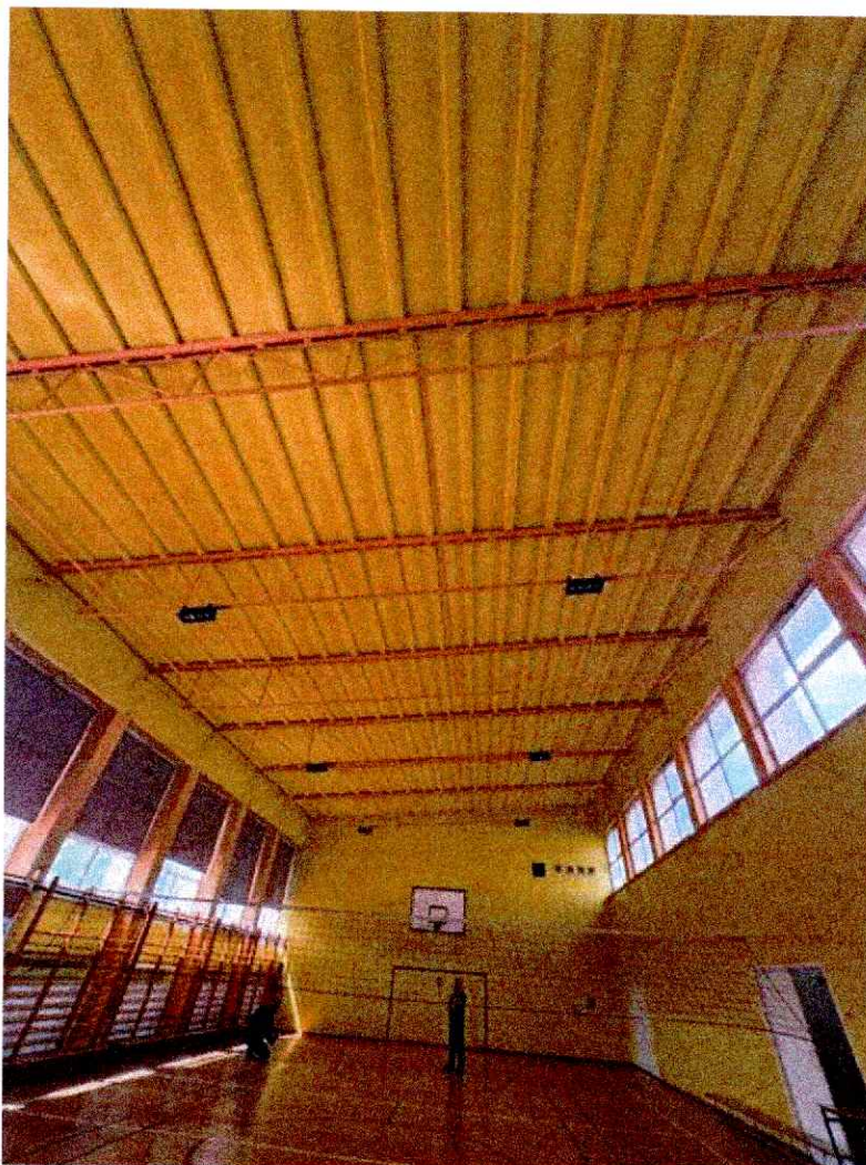
Fot. 6. Widok na dach Sali gimnastycznej od wewnątrz
