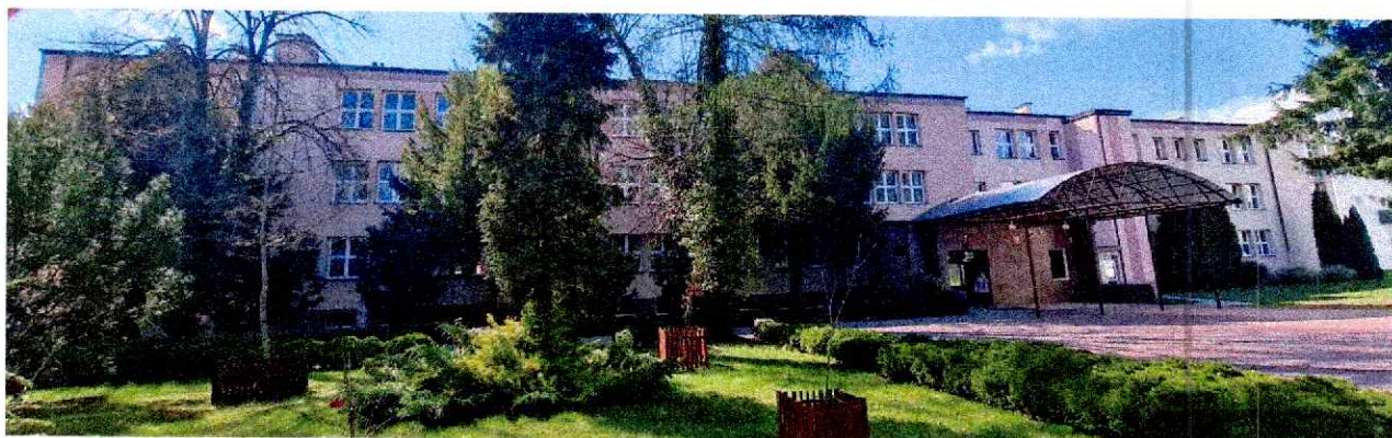
Fot.24. Widok na elewację wschodnią
