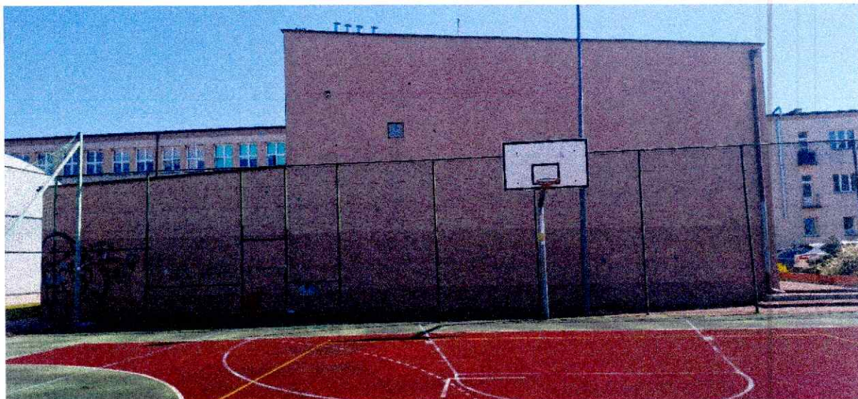
Fot 32. Sala gimnastyczna- elewacja zachodnia
