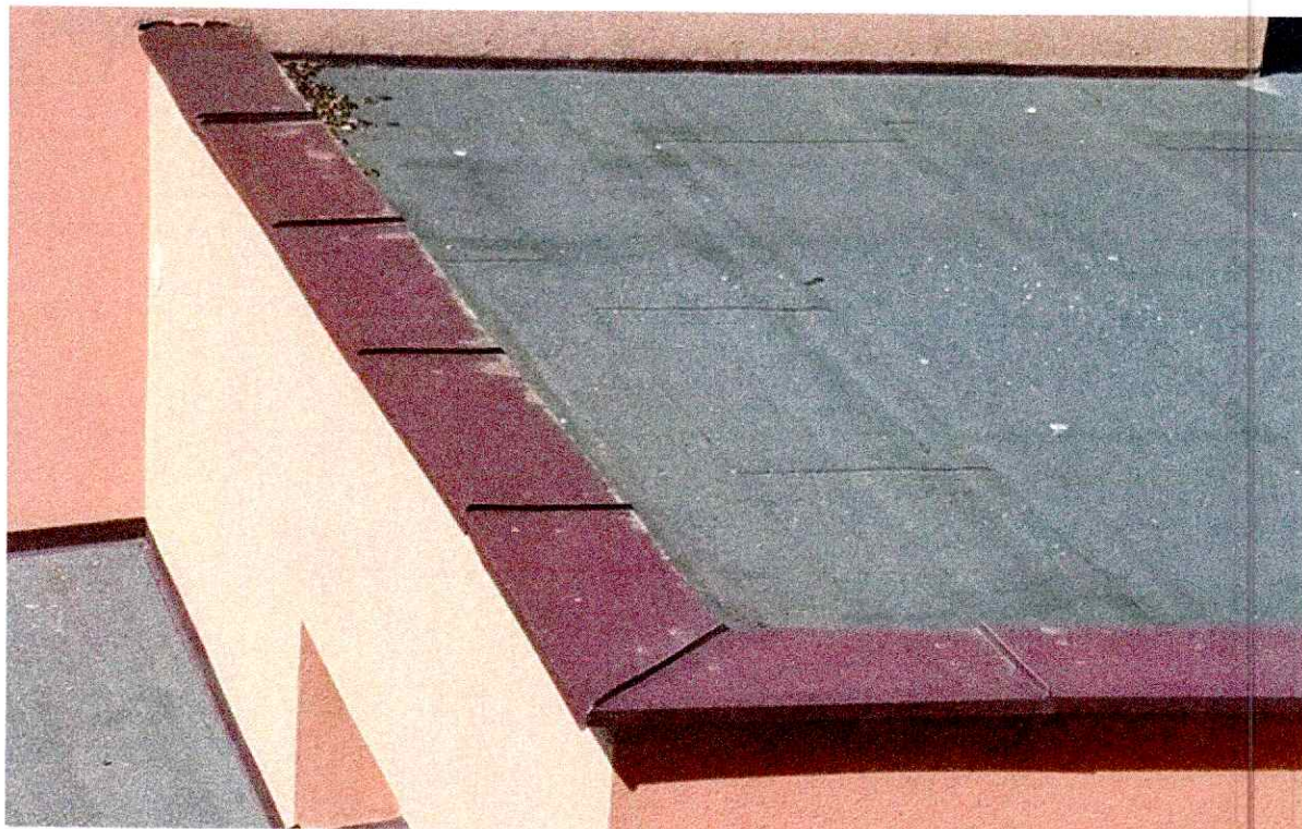
Fot. 14. Widok na obróbki blacharskie attyki
