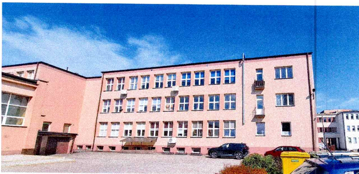
Fot.26. Widok na elewację zachodnią
