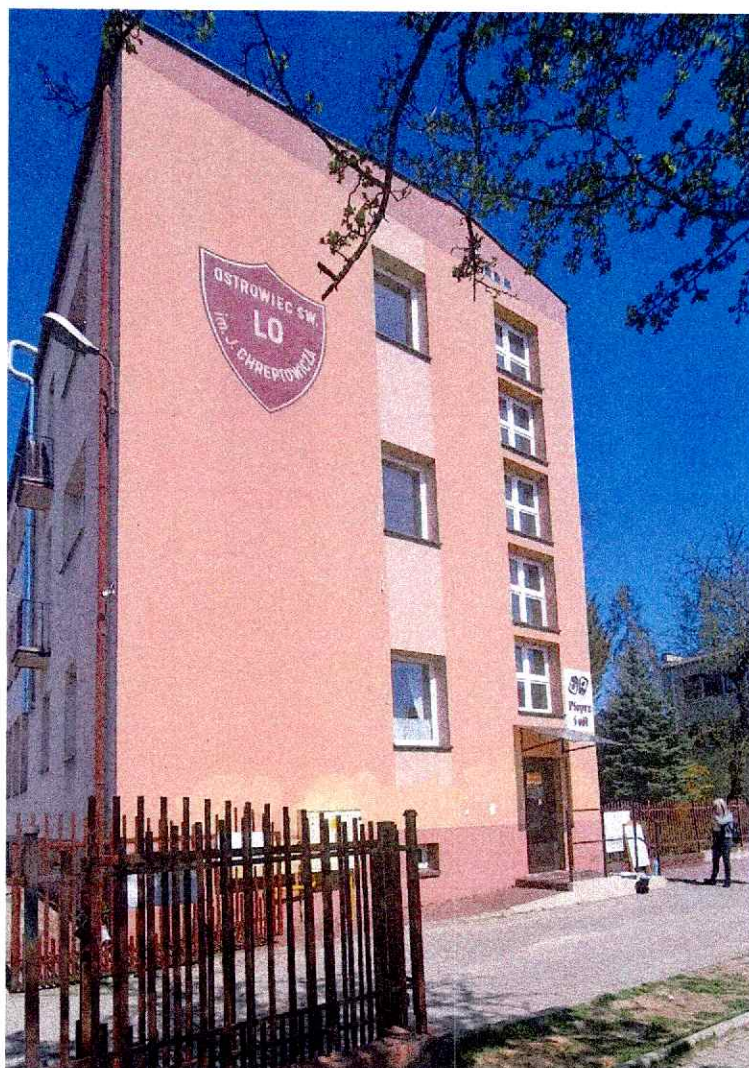
Fot.25. Widok na elewację południową
