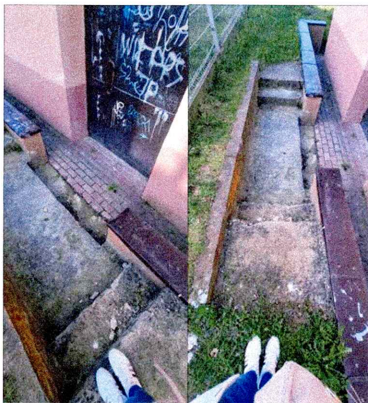
Fot. 15. Widok na schody zejścia do piwnicy
