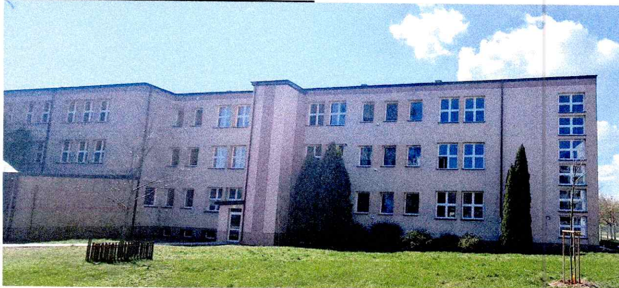
Fot.22. Widok na elewację wschodnią
