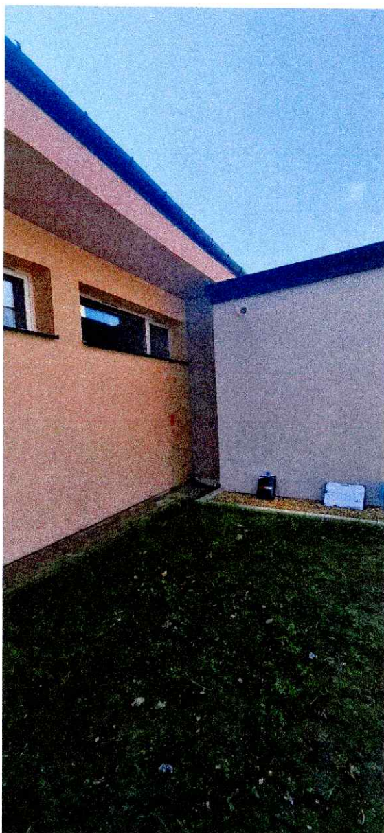
Fot.36. Sala gimnastyczna z zapleczem- elewacja północna- połączenie z łącznikiem
