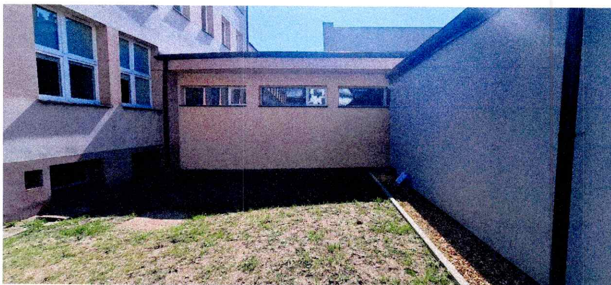
Fot.35. Sala gimnastyczna z zapleczem- elewacja północna
