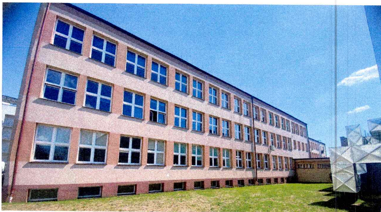
Fot.27. Widok na elewację zachodnią
