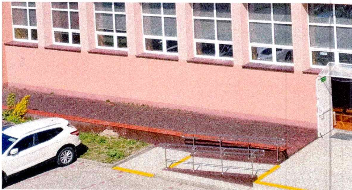
Fot. 20. Widok na murek wzdłuż sali gimnastycznej
