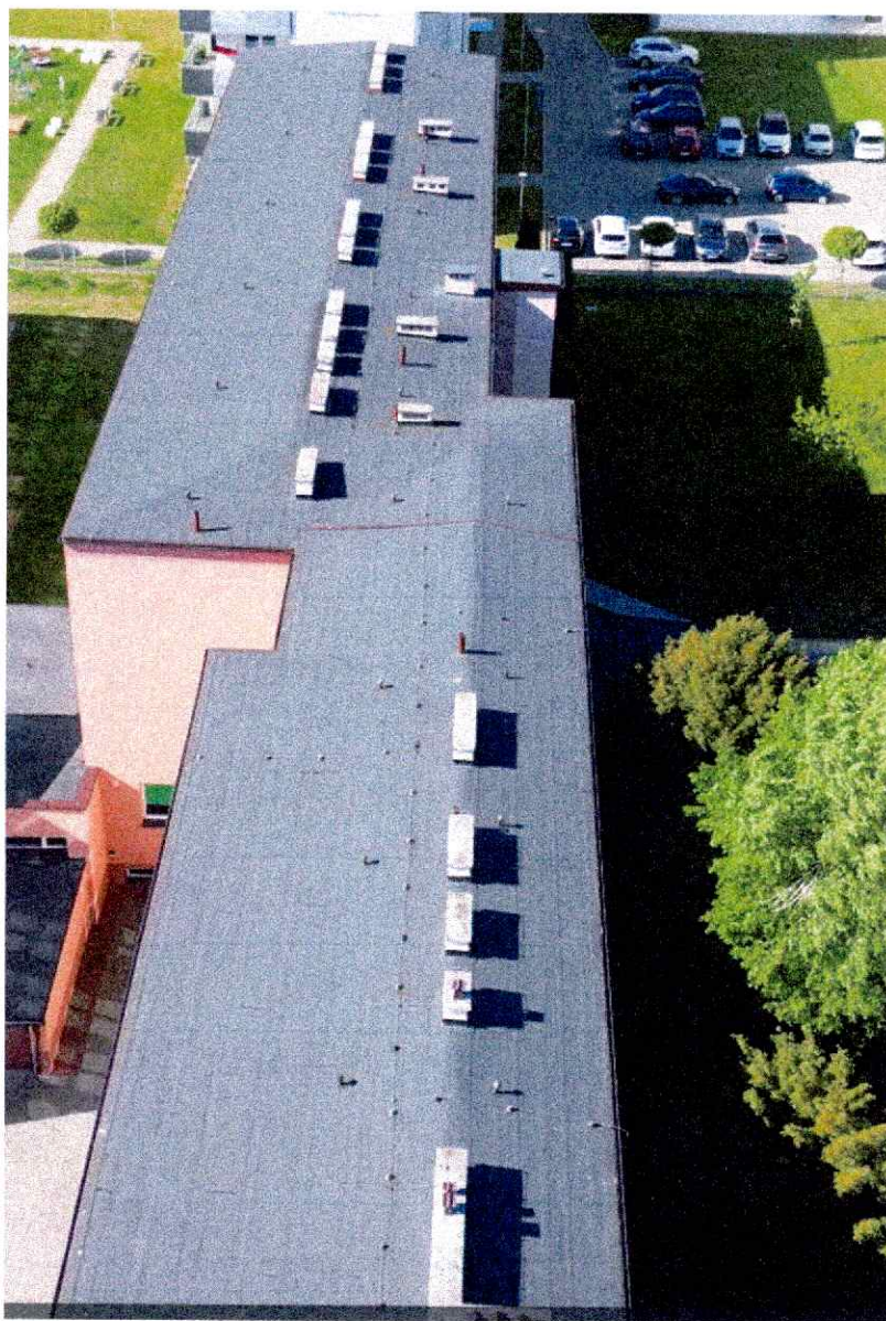
Fot.39 Widok na dach nad szkołą
