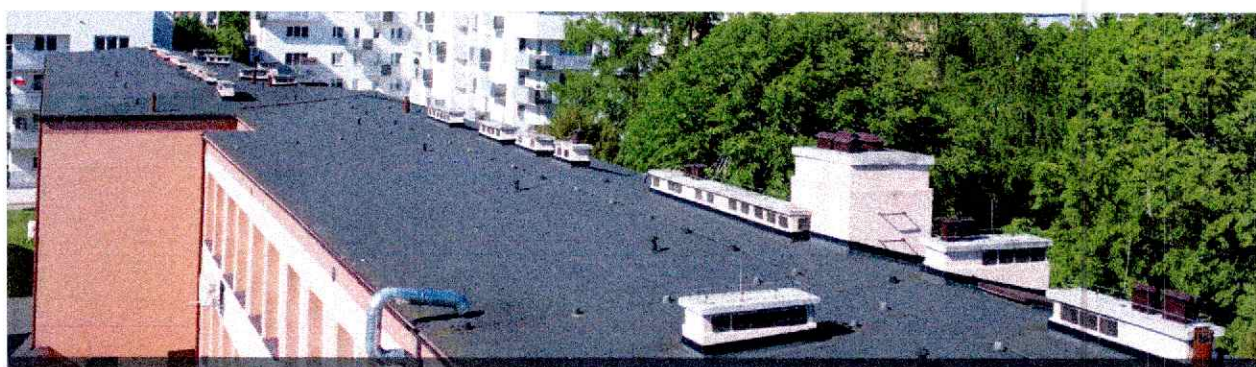
Fot.38. Widok na dach nad szkołą
