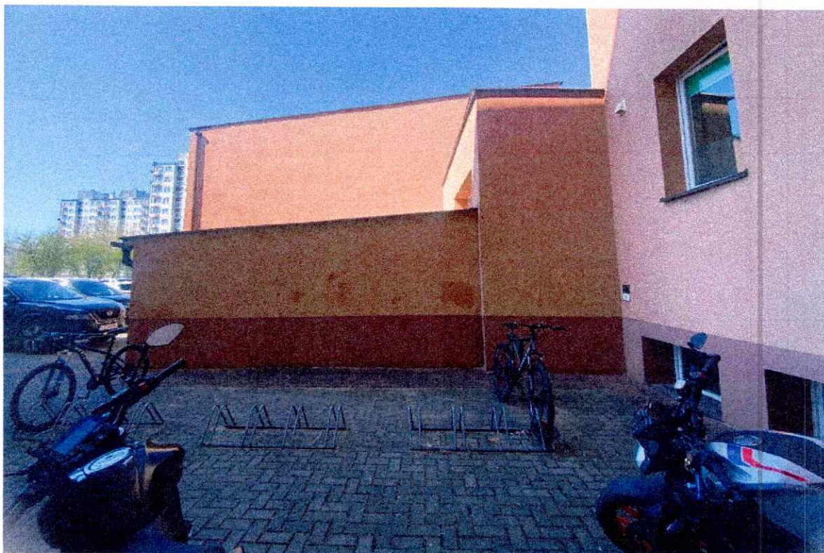
Fot.30 Sala gimnastyczna- Widok na elewację wschodnią
