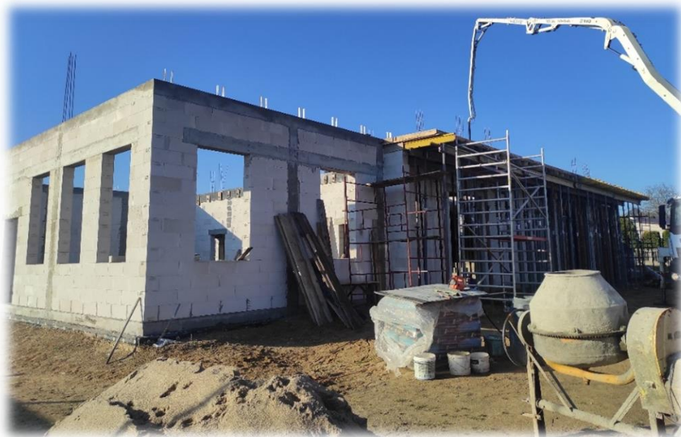
Zdjęcie 5. Budowa Remizy Ochotniczej Straży Pożarnej w Domanowie
