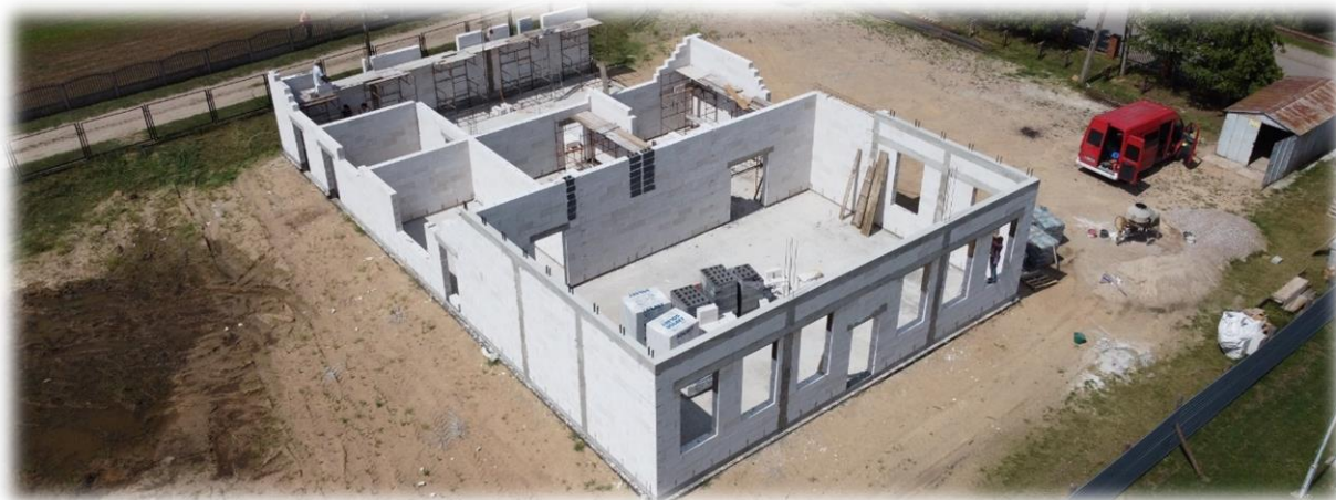
Zdjęcie 6. Budowa Remizy Ochotniczej Straży Pożarnej w Domanowie
