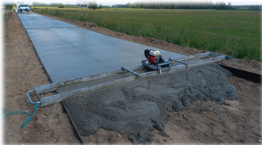
Zdjęcie 2. Przebudowa drogi gminnej Chojewo – Pace Nr 108246B
