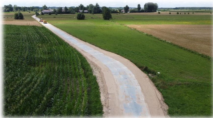
Zdjęcie 4. Przebudowa drogi gminnej Chojewo – Pace Nr 108246B
