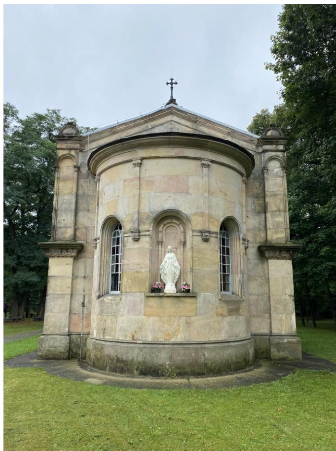
Fot. nr 3. Ruda Maleniecka. Kaplica podworska p.w. Św. Judy Tadeusza. Elewacja zachodnia kaplicy z prezbiterium.
