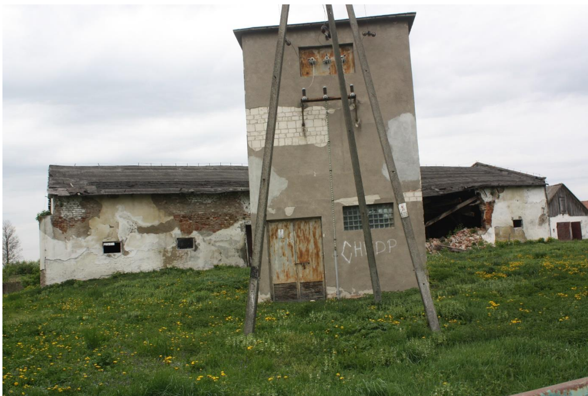
Budynki po byłym PGR znajdujące się w obszarze rewitalizacji
