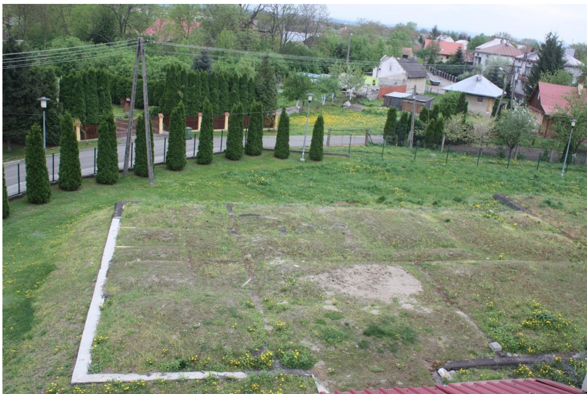
Fundament pod budynek socjalny przy Hali sportowej
