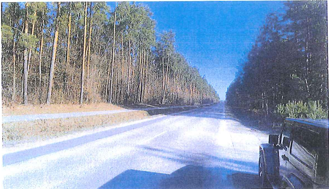
Fot. 1 Odcinek jezdni drogi powiatowej nr 1611T przy zjeździe na Kopalnię „Stara Dębowa Wola” – bez śladów zanieczyszczeń (błota, pyłów mineralnych)
