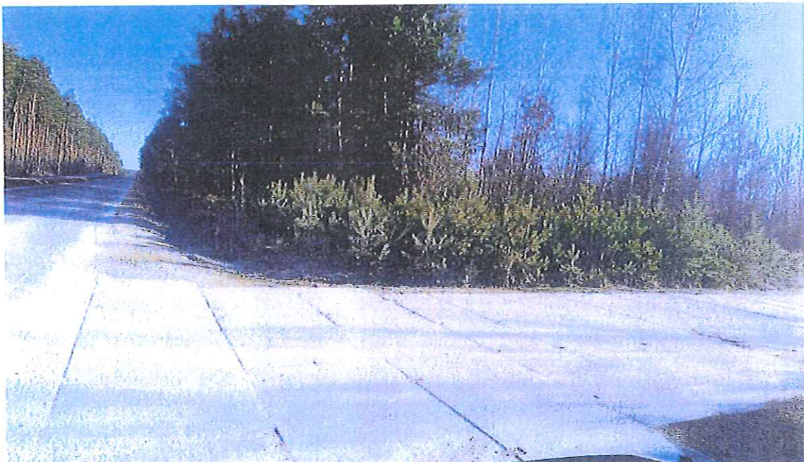
Fot. 2 Wyłożony płytami betonowymi odcinek zjazdu z drogi powiatowej nr 1611T na drogę prowadzącą bezpośrednio do Kopalni „Stara Dębowa Wola” – również w należytym stanie, bez zanieczyszczeń.
