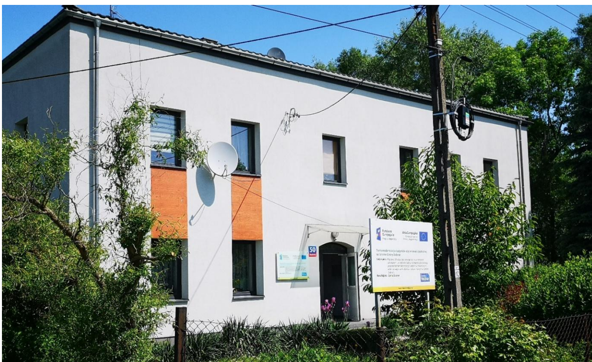
Fot. Budynek komunalny Markówka 50. Źródło: archiwum UG Dobroń.
