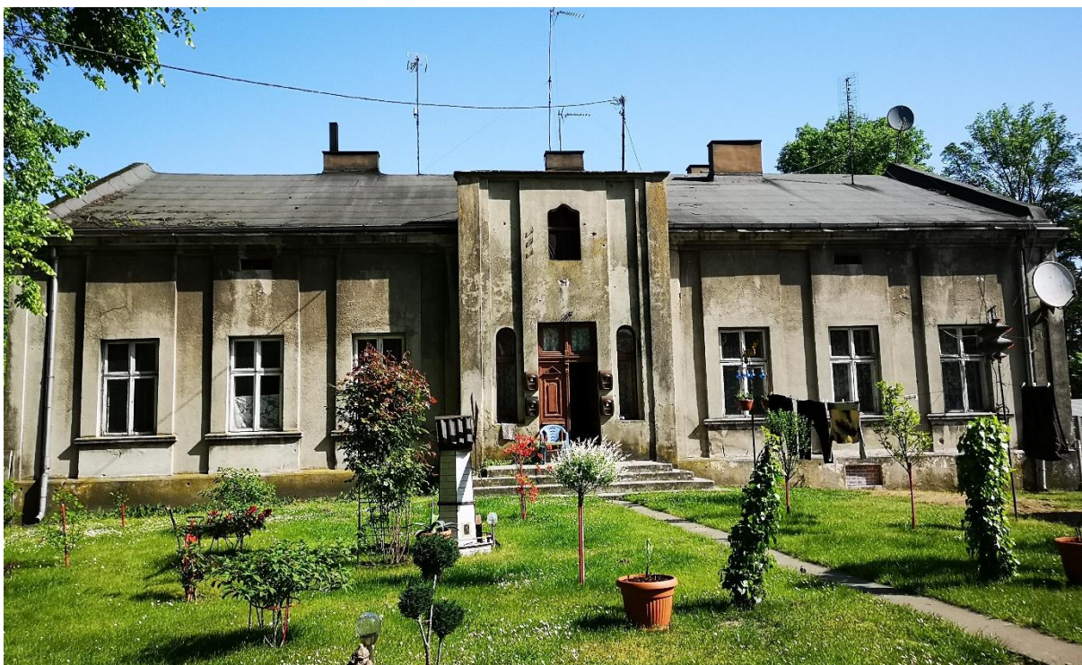
Fot. Budynek komunalny w miejscowości Talar. Źródło: archiwum UG Dobroń.
