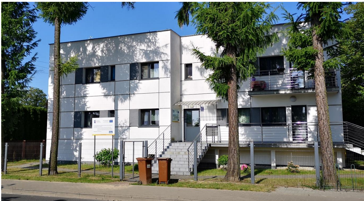
Fot. Budynek komunalny Dobroń ul. 11 Listopada 11. Źródło: archiwum UG Dobroń.
