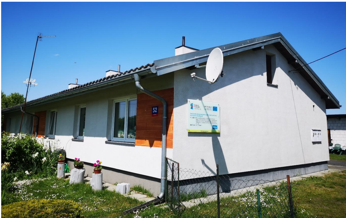
Fot. Budynek komunalny Markówka 52. Źródło: archiwum UG Dobroń.
