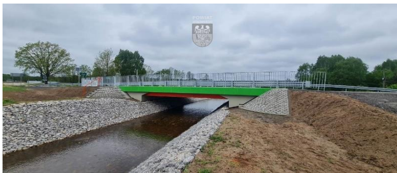
Fot. 19 Most nad rzeką Cienką w miejscowości Kury
