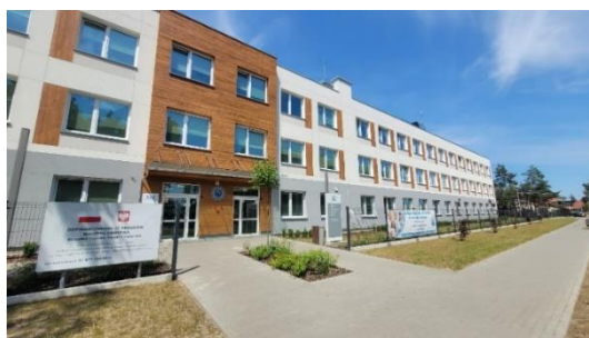
Fot. 16 Nowy budynek szpitala powiatowego w Wołominie
