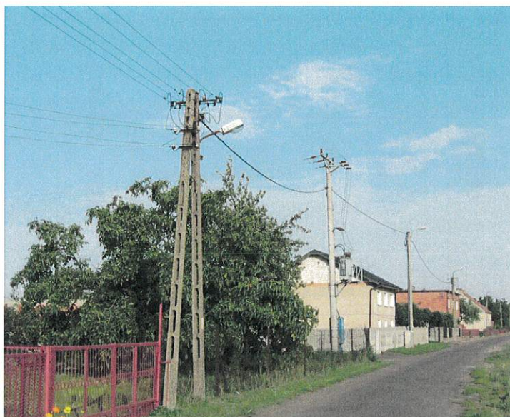
Fot. 5. Linie dystrybucyjne nn-0,4 kV (przykłady)
