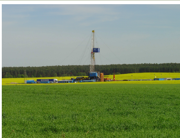
Fot.16. Odwiert „Radoszyn 4k”
