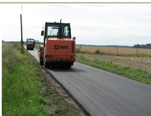
Fot.5. Remont drogi 1224F: Radoszyn-Darnawa
