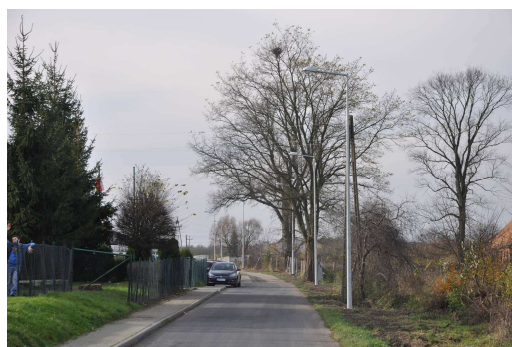
Fot.7. Budowa punktów świetlnych wzdłuż drogi dojazdowej do gimnazjum
