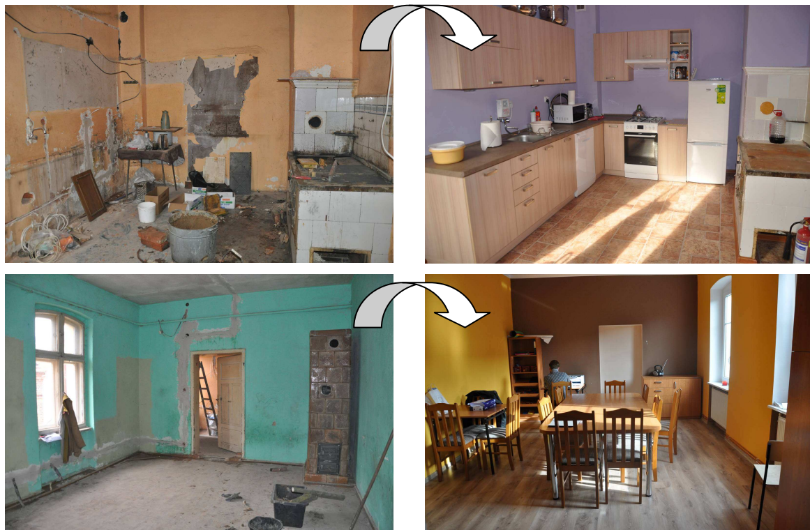
Fot.10. Remont obiektu pełniące funkcję świetlicy wiejskiej (stan przed i po realizacji)
