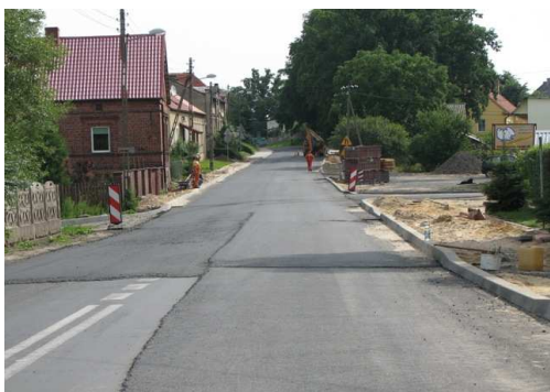
Fot.4. Remont drogi wojewódzkiej nr 276
