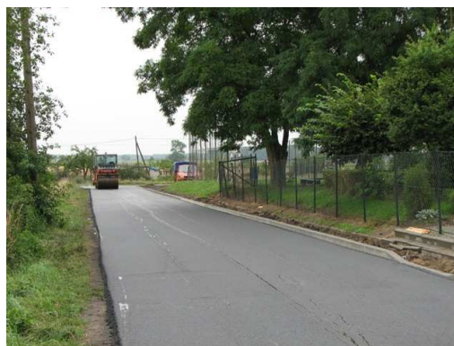
Fot.6. Remont drogi dojazdowej do gimnazjum
