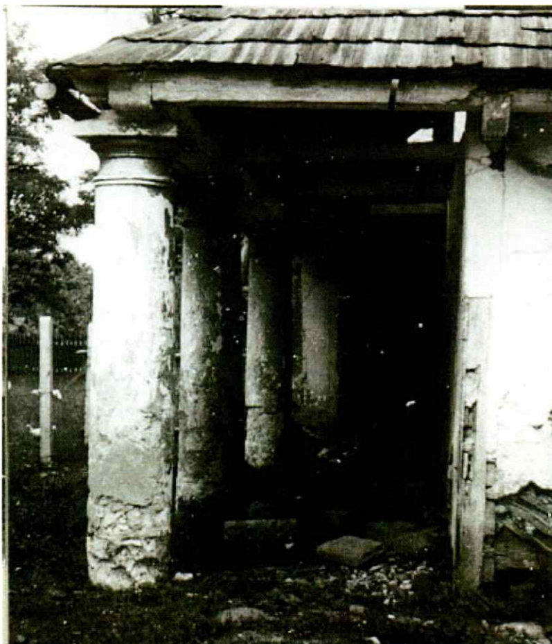
Fot. 8. Podcień, widok od południa, stan przed remontem/ rekonstrukcją domu [z: Karta ewidencyjna, tzw. zielona, Budynek dawnej karczmy, Solec , oprac. podpis nieczytelny , 1960].
