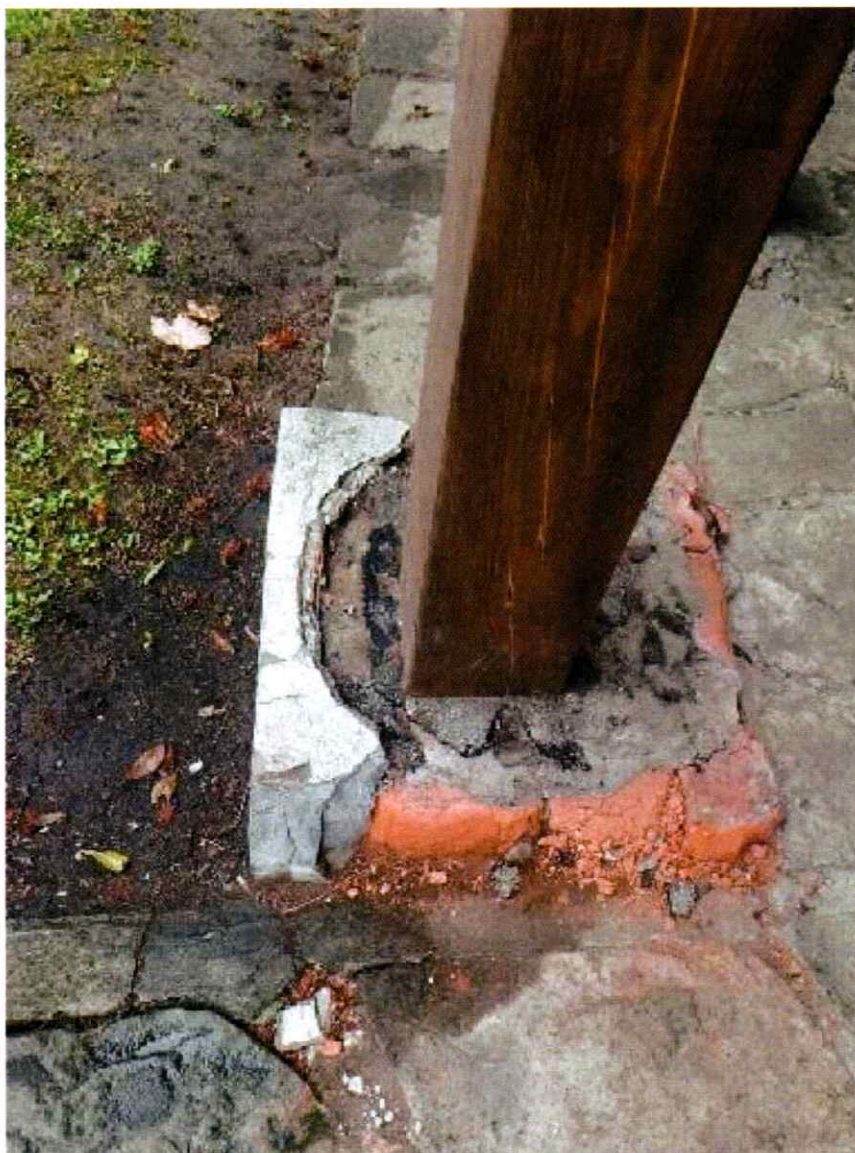
Fot. 2. Posadowienie tymczasowego słupa, na reliktach bazy zniszczonej kolumny, 2024.
