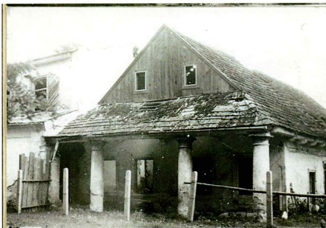
Fot. 6. Widok na elewację frontową, stan przed remontem/rekonstrukcją domu [z: Karta ewidencyjna, tzw. zielona, Budynek dawnej karczmy, Solec , oprac. podpis nieczytelny , 1960].
