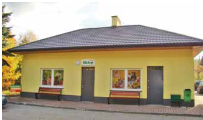
Odnowiony budynek poczekalni w Lubeni
