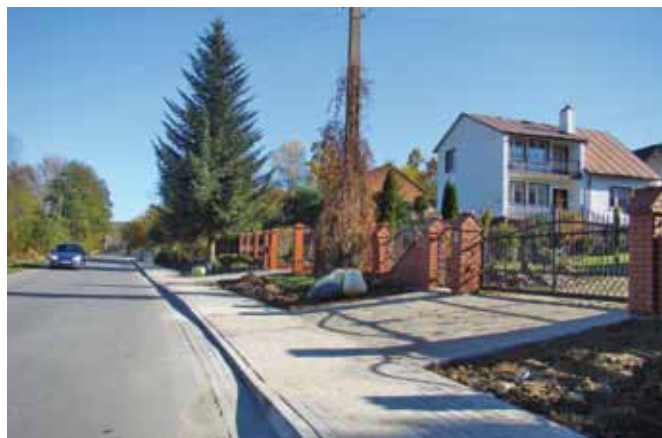
Przebudowa drogi powiatowej
