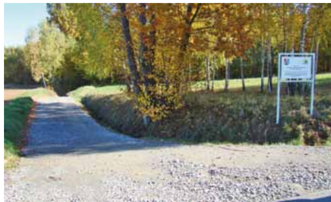
Naprawa infrastruktury drogowej w Straszdydle
