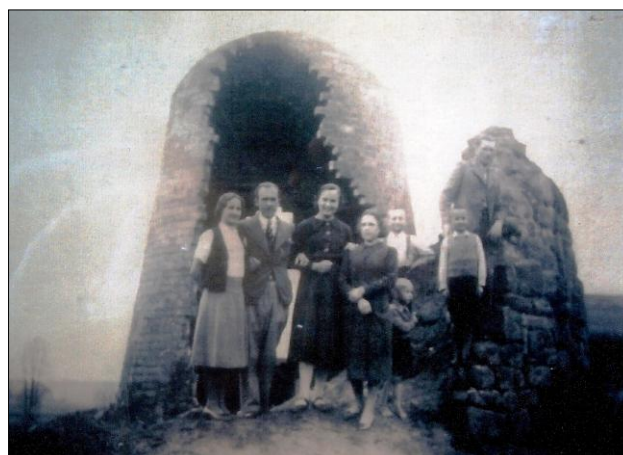
Fot. Pozostałości pieców murowanych do pirolizy -1938
