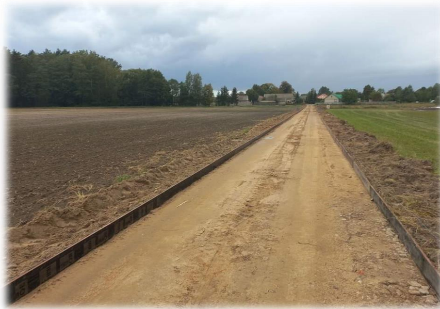
Zdjęcie nr 1. Przebudowa ciągu pieszego m. Bronka- w trakcie robót
