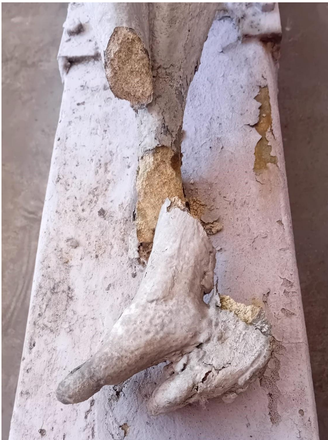
Fot. nr 17. Ujęcie frontalne dolnych partii figury Jezusa – dobrze widoczny katastrofalny stan zachowania figury, znaczna dezintegracja granularna substancji kamienia, liczne ubytki formy, erozja warstw barwnych. Fot. G. Mienkiewicz, kwiecień 2024 r.
