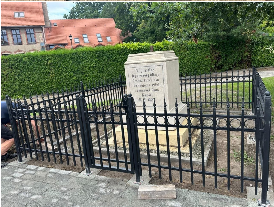
Fot. nr 56-57. Ujęcie w trakcie montażu obiektu w nowym miejscu ekspozycji. Dobrze widoczne nowe ogrodzenie metalowe wraz z nowym posadowieniem. Fot. G. Mienkiewicz, sierpień 2024 r.
