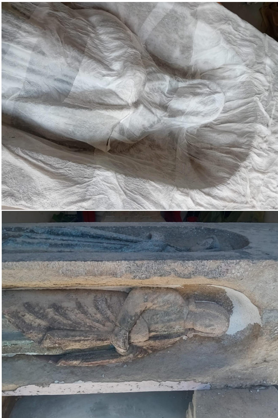
Fot. nr 26-27. Ujęcie na cokół z figurą Św. Jana i Matki Boskiej – dobrze widoczny stan zachowania kamienia po oczyszczeniu z powłok malarskich i szlicht cementowych, wyraźna erozja lica substancji kamienia, przebarwienia powierzchni. Fot. G. Mienkiewicz, czerwiec 2024 r.
