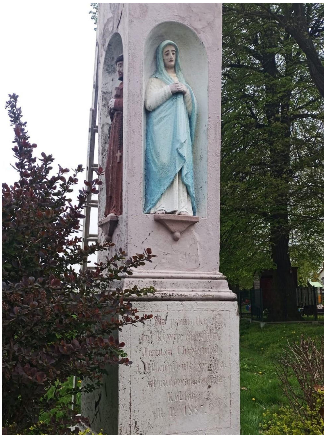
Fot. nr 5. Stan zachowania obiektu przed konserwacją, ujęcie na figurę matki Boskiej i Św. Franciszka. Fot. Katanga, kwiecień 2024 r.
