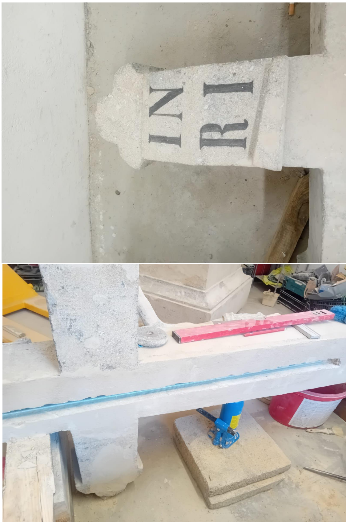
Fot. nr 54-55. Ujęcie na oczyszczony i uczytelniony akronim krzyża, dobrze widoczne wzmocnienie konstrukcyjne wklejone w plecy krzyża. Fot. G. Mienkiewicz, lipiec 2024 r.
