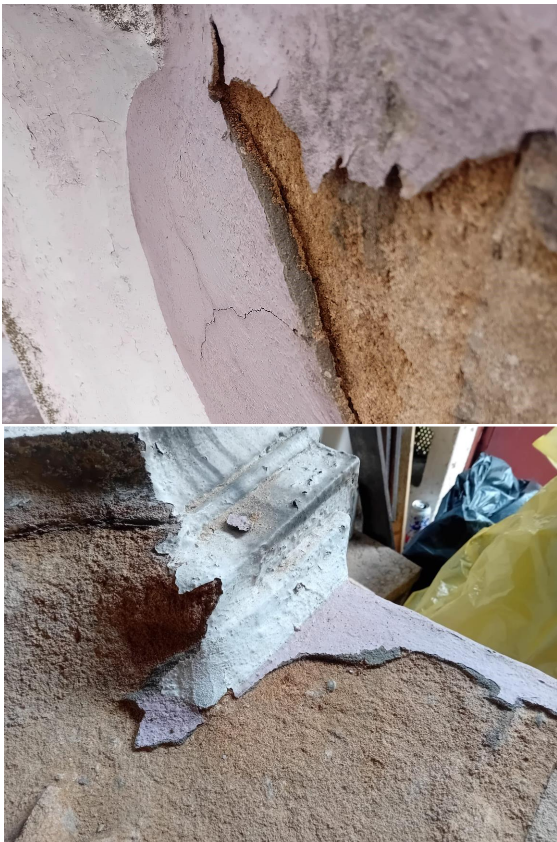
Fot. nr 12-13. Widok na górną część cokołu po demontażu. Dobrze widoczna gruba warstwa cementu i przemalowań odspojona od kamienia. Fot. G. Mienkiewicz, kwiecień 2024 r.
