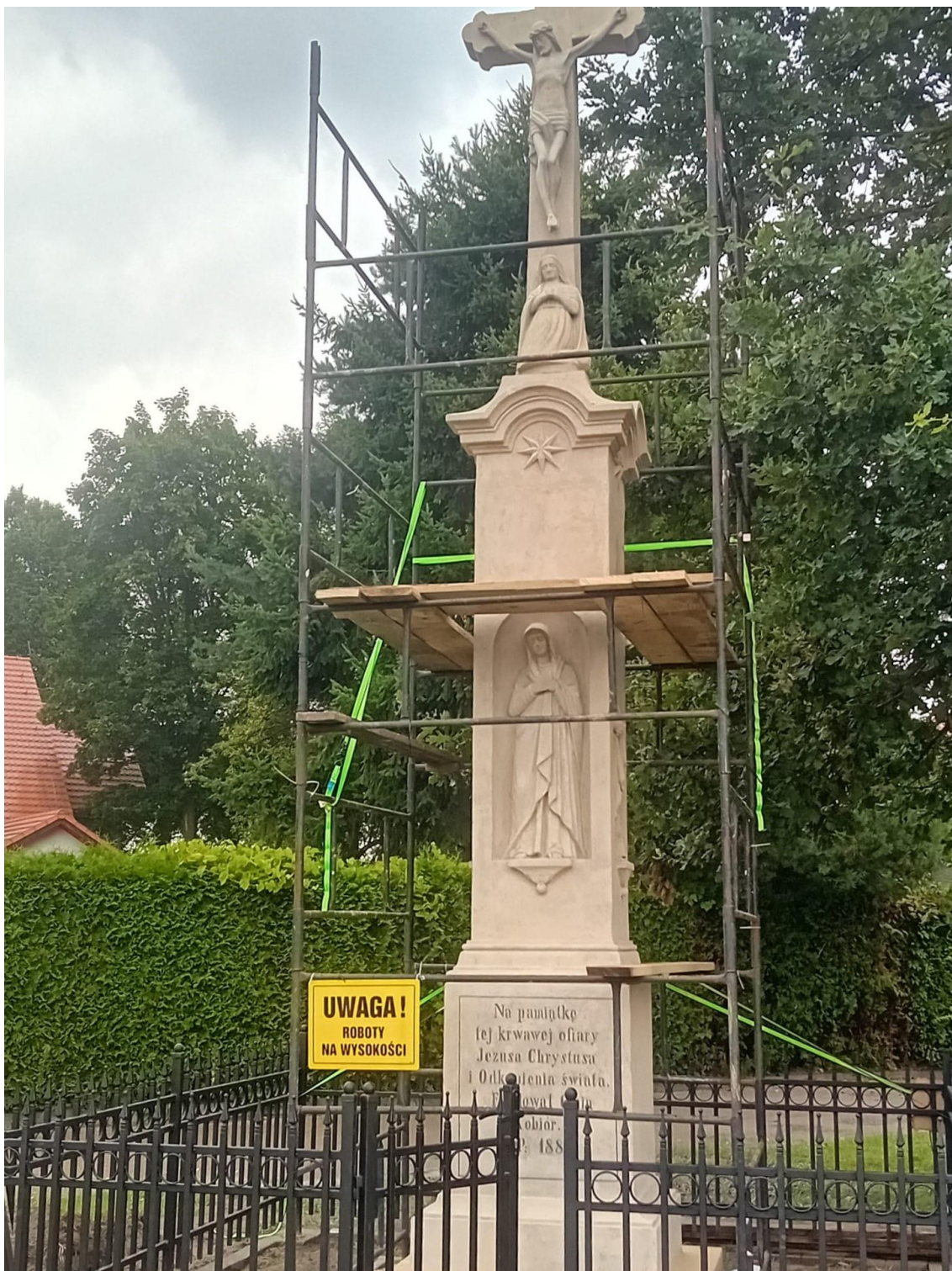
Fot. nr 59. Ujęcie po montażu obiektu w nowym miejscu ekspozycji – prace finiszowe, hydrofobizacja. Fot. G. Mienkiewicz, sierpień 2024 r.
