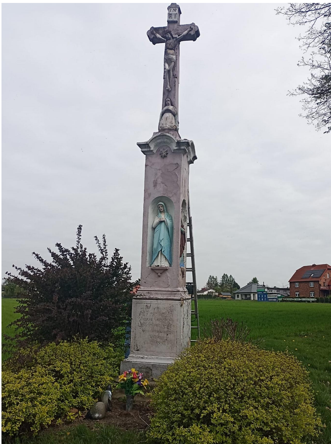
Fot. nr 1. Stan zachowania obiektu przed konserwacją, widok z frontu Fot. Katanga, kwiecień 2024 r.
