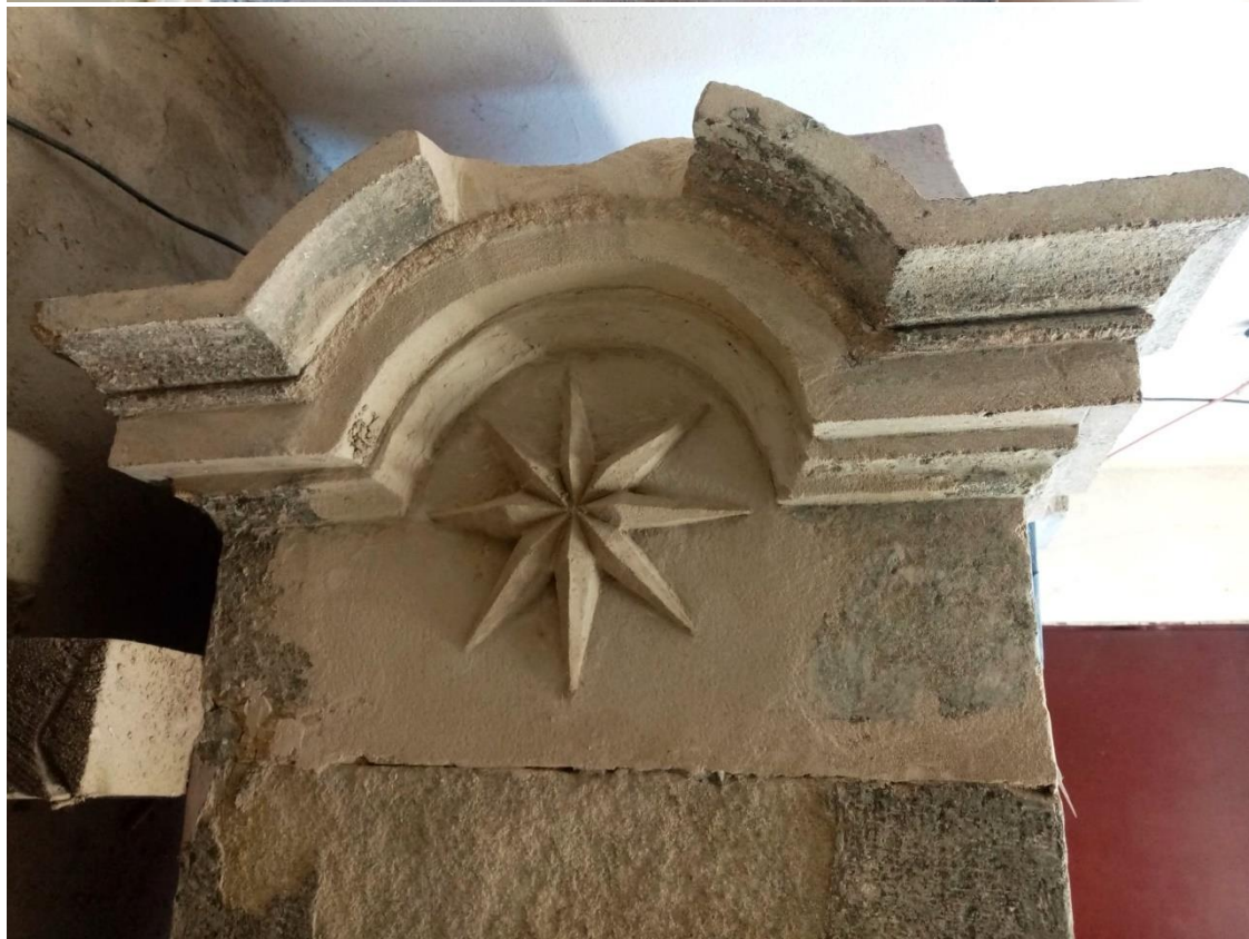
Fot. nr 43-44. Ujęcie na elementy cokołu w trakcie uzupełniania ubytków formy. Dobrze widoczne gniazdo pod flek. Fot. G. Mienkiewicz, lipiec 2024 r.
