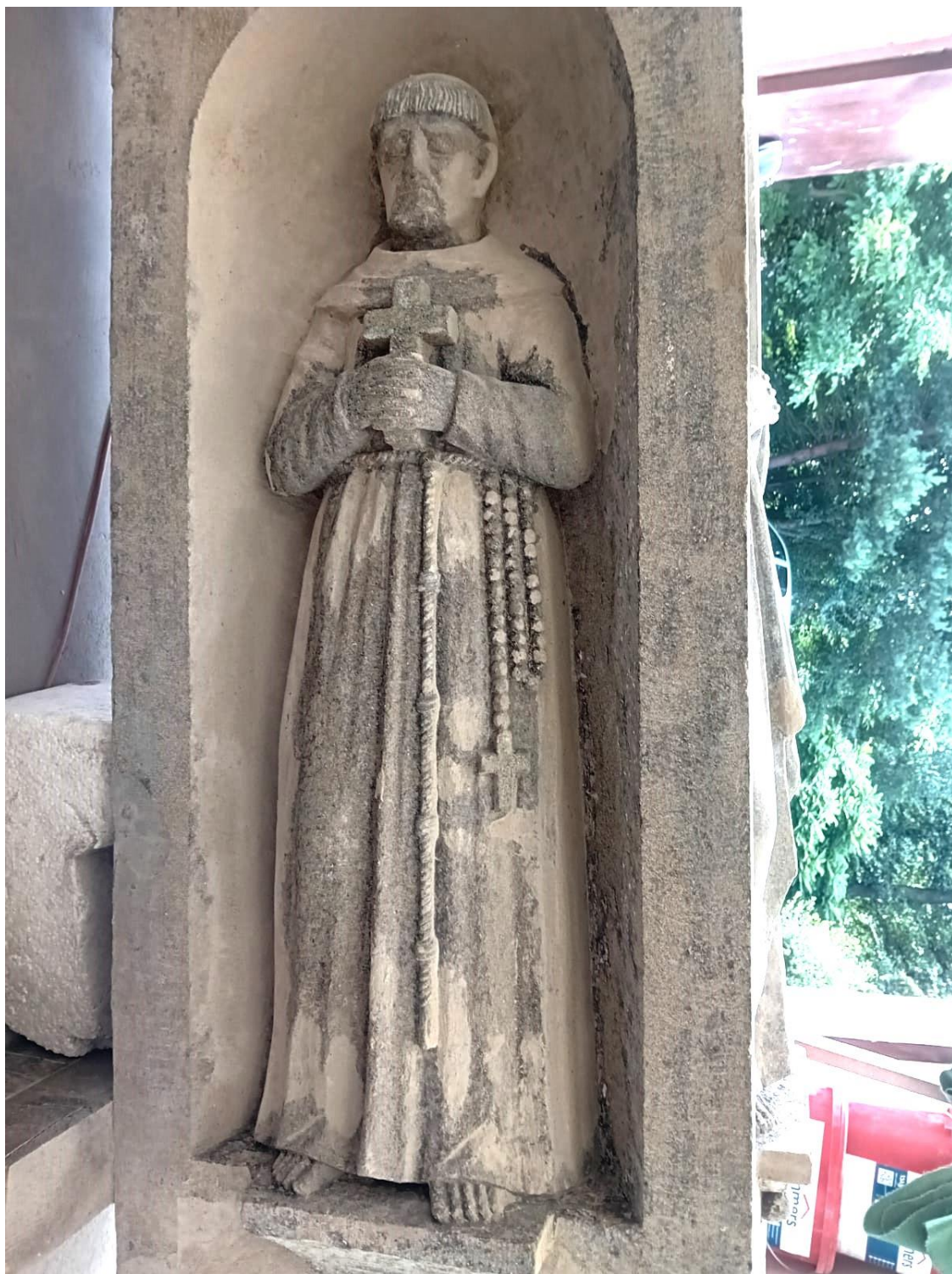
Fot. nr 49. Ujęcie na figure Św. Franciszka w trakcie uzupełniania ubytków formy. Dobrze widoczne uzupełnienia w masie mineralnej. Fot. G. Mienkiewicz, lipiec 2024 r.
