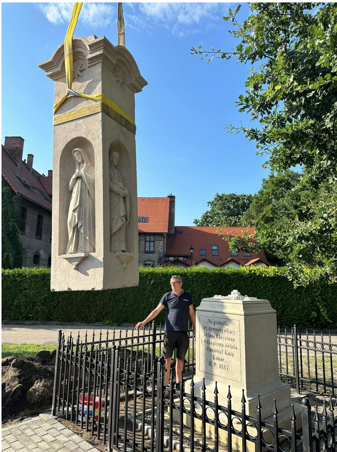
Fot. nr 58. Ujęcie w trakcie montażu obiektu w nowym miejscu ekspozycji – montaż górnego elementu cokołu. Fot. G. Mienkiewicz, sierpień 2024 r.
