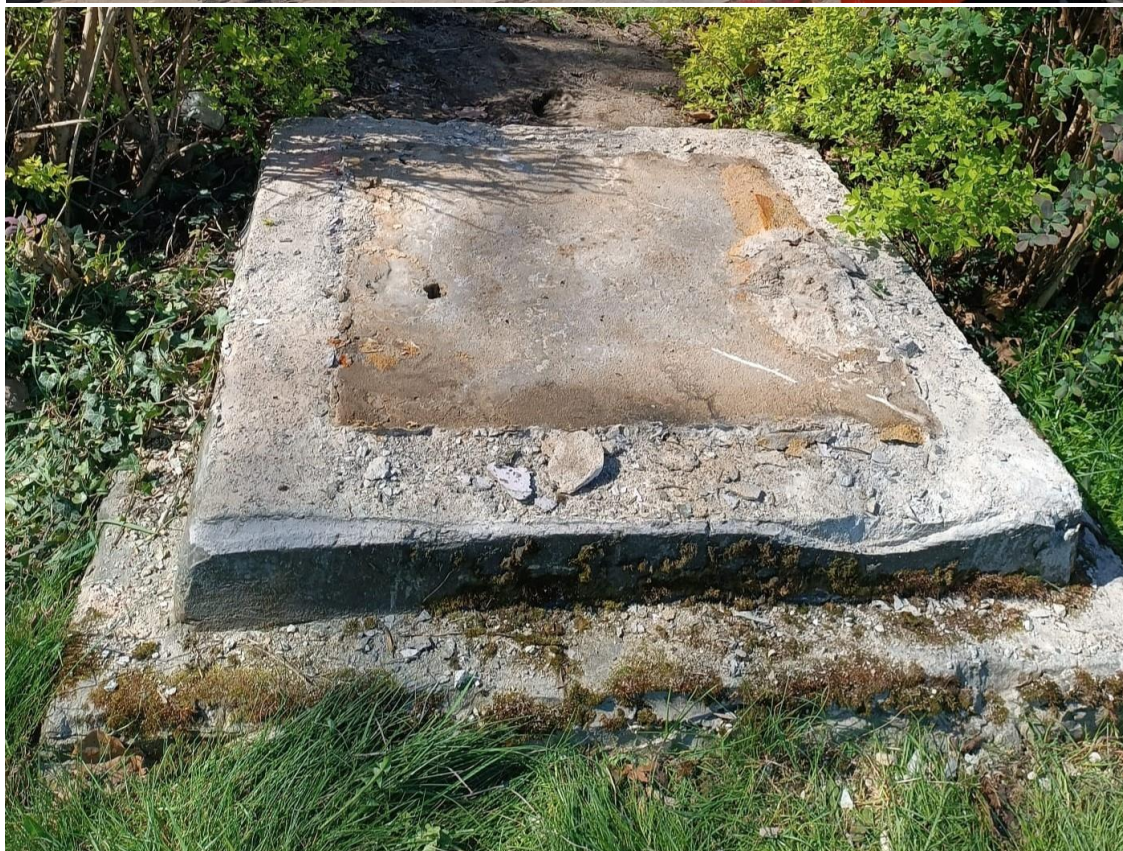
Fot. nr 9-10. Widok w trakcie demontażu pomnika, ujęcie na stare posadowienie obiektu. Fot. G. Mienkiewicz, kwiecień 2024 r.
