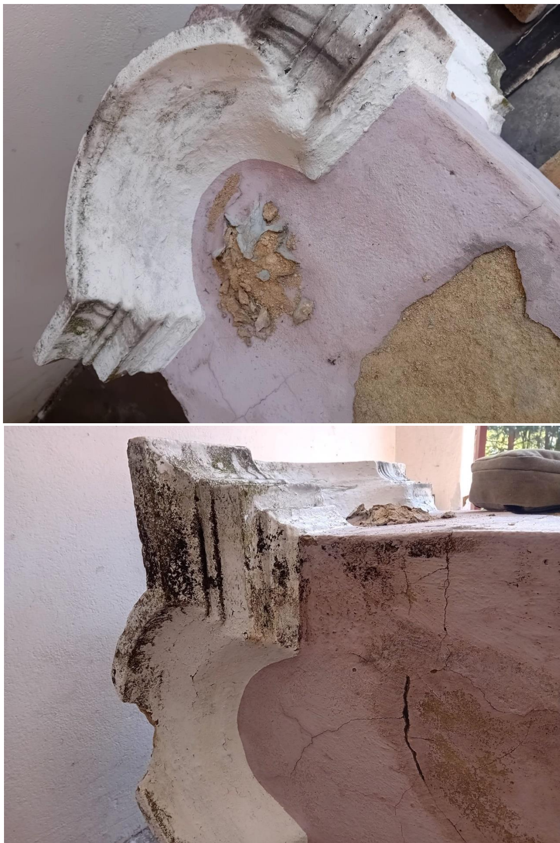
Fot. nr 11. Widok na górną część cokołu po demontażu. Fot. G. Mienkiewicz, kwiecień 2024 r.
