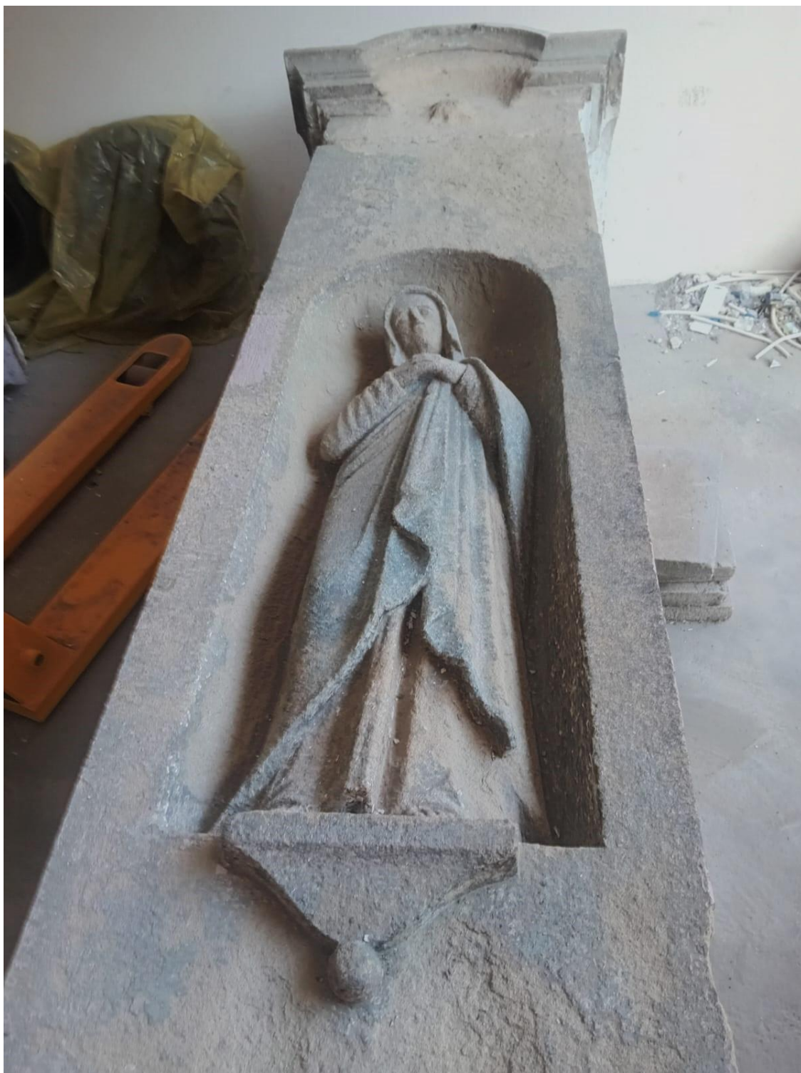
Fot. nr 25. Ujęcie na cokół z figurą Matki Boskiej – dobrze widoczny stan zachowania kamienia po oczyszczeniu z powłok malarskich i szlicht cementowych, wyraźna erozja lica substancji kamienia. Fot. G. Mienkiewicz, czerwiec 2024 r.
