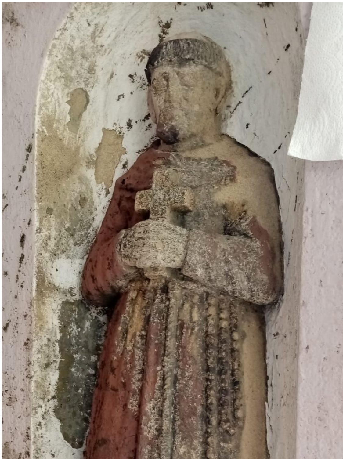
Fot. nr 24. Ujęcie na cokół z figurą ŚW. Franciszka – dobrze widoczny stan zachowania kamienia po oczyszczeniu z powłok malarskich i szlicht cementowych, wyraźna erozja lica substancji kamienia. Fot. G. Mienkiewicz, czerwiec 2024 r.
