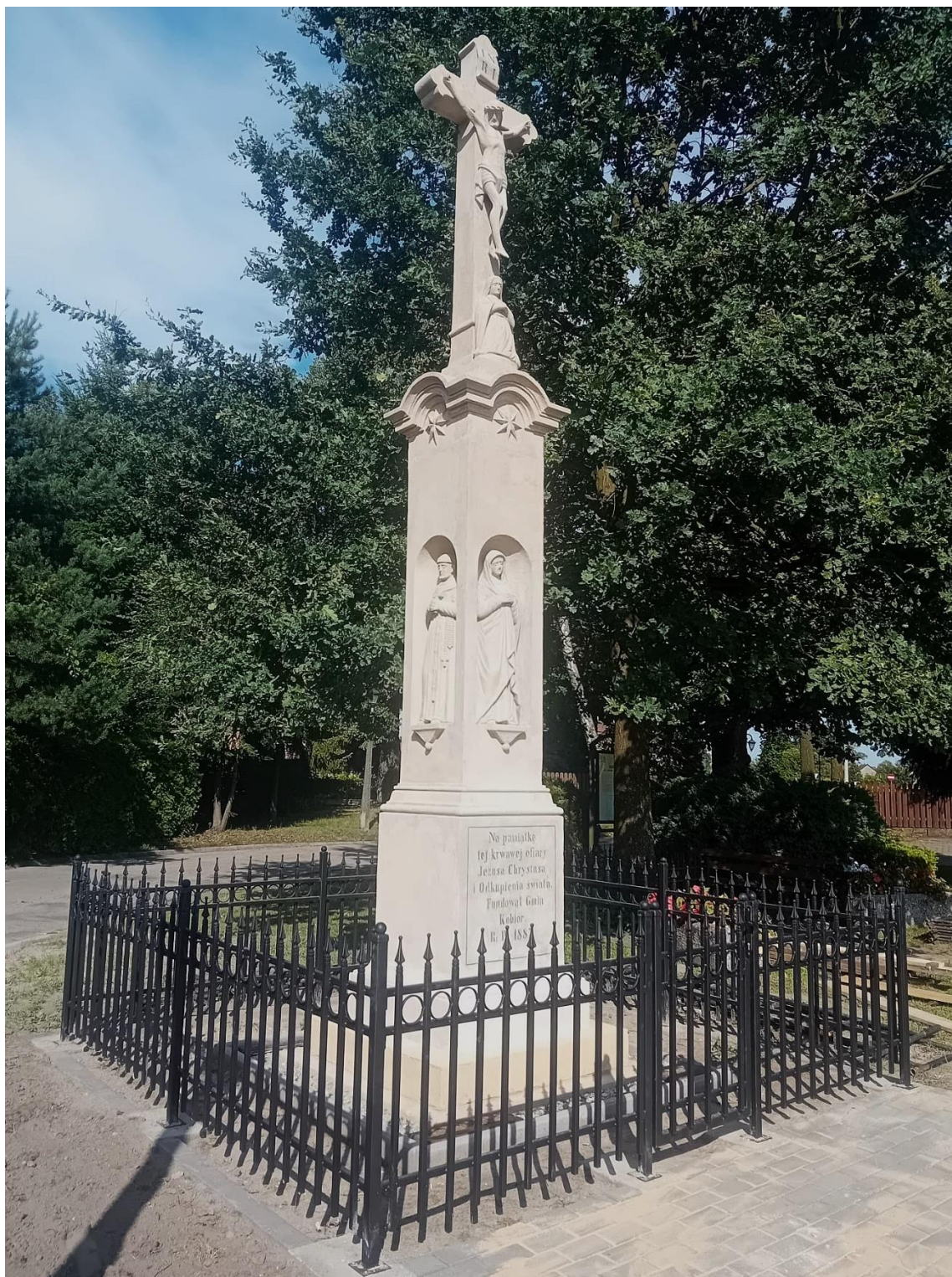
Fot. nr 71. Ujęcie ogólne obiektu po zakończeniu prac konserwatorskich – widok z przodu z 3/4. Fot. G. Mienkiewicz, sierpień 2024 r.
