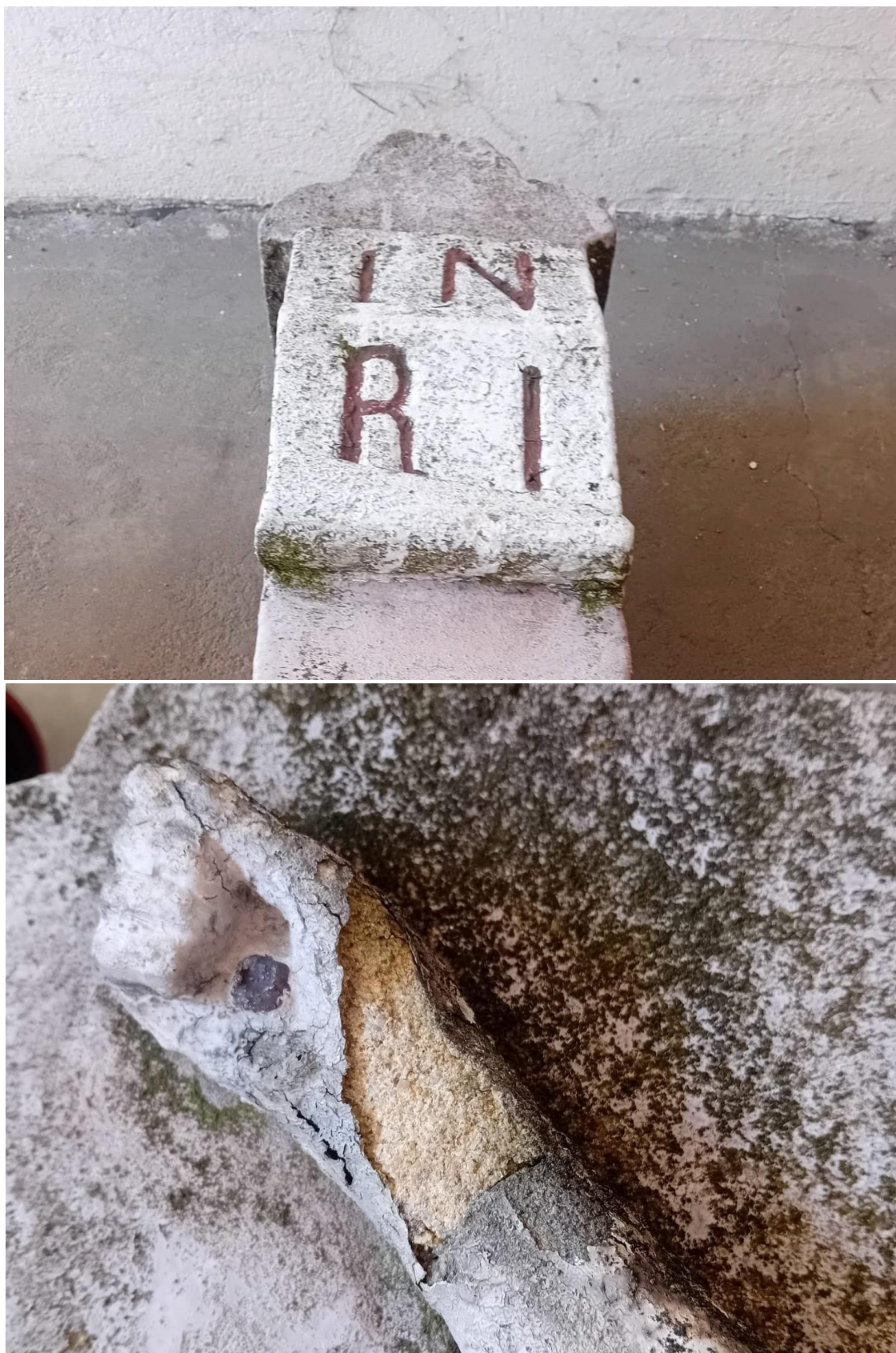
Fot. nr 18-19. Ujęcie na akronim z tabliczki i dłoń Jezusa – dobrze widoczny katastrofalny stan zachowania figury, znaczna dezintegracja granularna substancji kamienia, liczne ubytki formy, erozja warstw barwnych. Fot. G. Mienkiewicz, kwiecień 2024 r.
