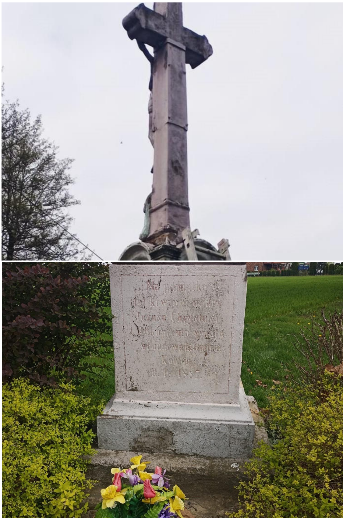
Fot. nr 6-7. Stan zachowania obiektu, detal-dobrze widoczna konstrukcja spinająca krzyż oraz erozja czcionki na dolnym elemencie cokołu. Fot. Katanga, kwiecień 2024 r.
