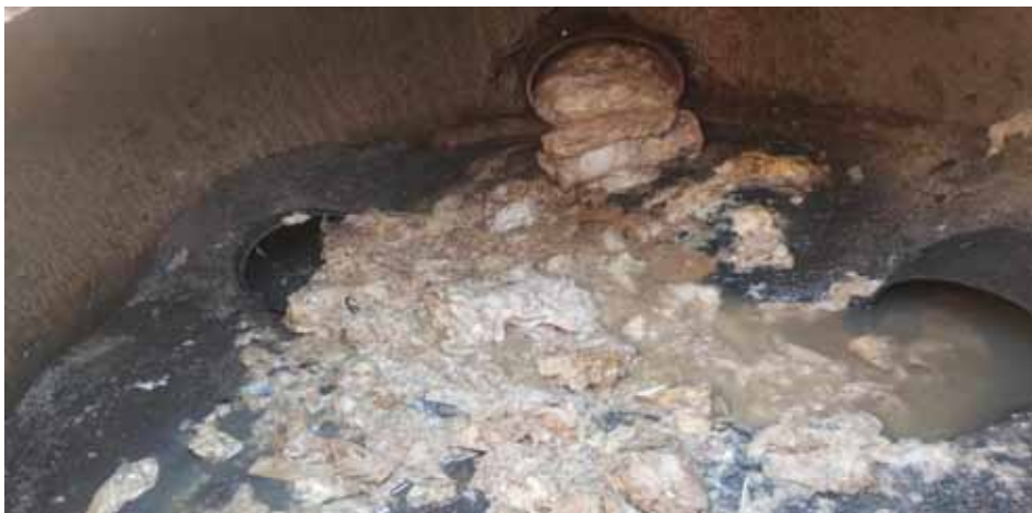
Chusteczki nawilżane, nierozpuszczalne w kolektorze ściekowym Zdj. Zbigniew Mazurek
