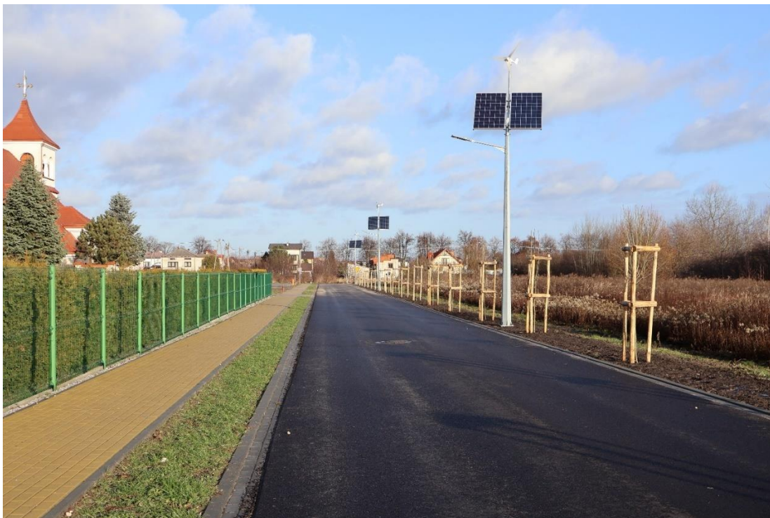
Przebudowana ul. Radosna
