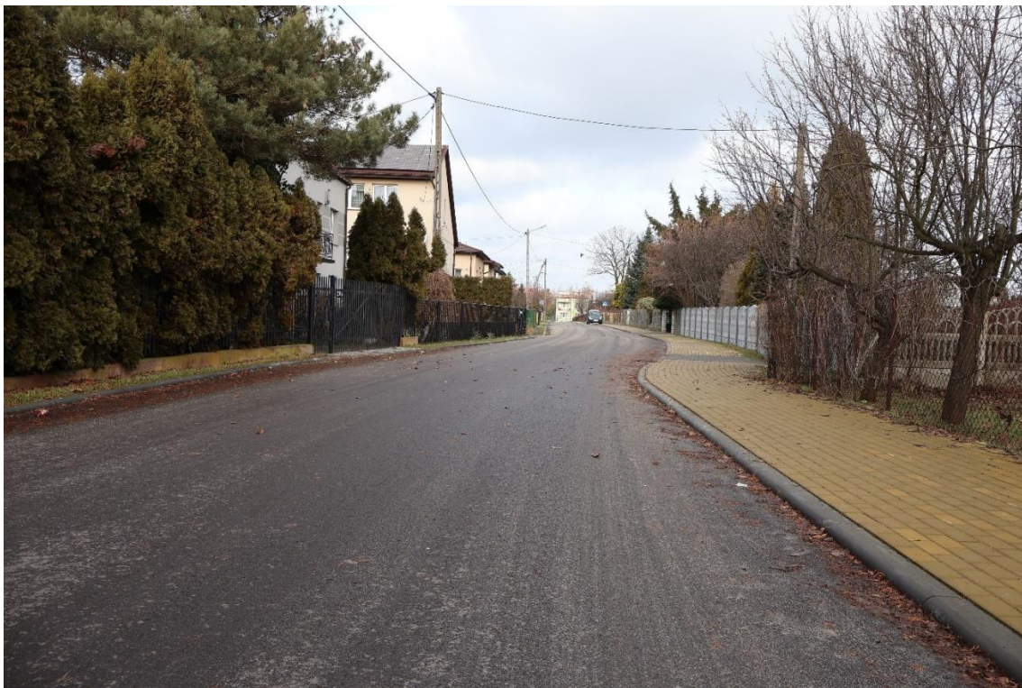
Przebudowana ul. Cielątki
