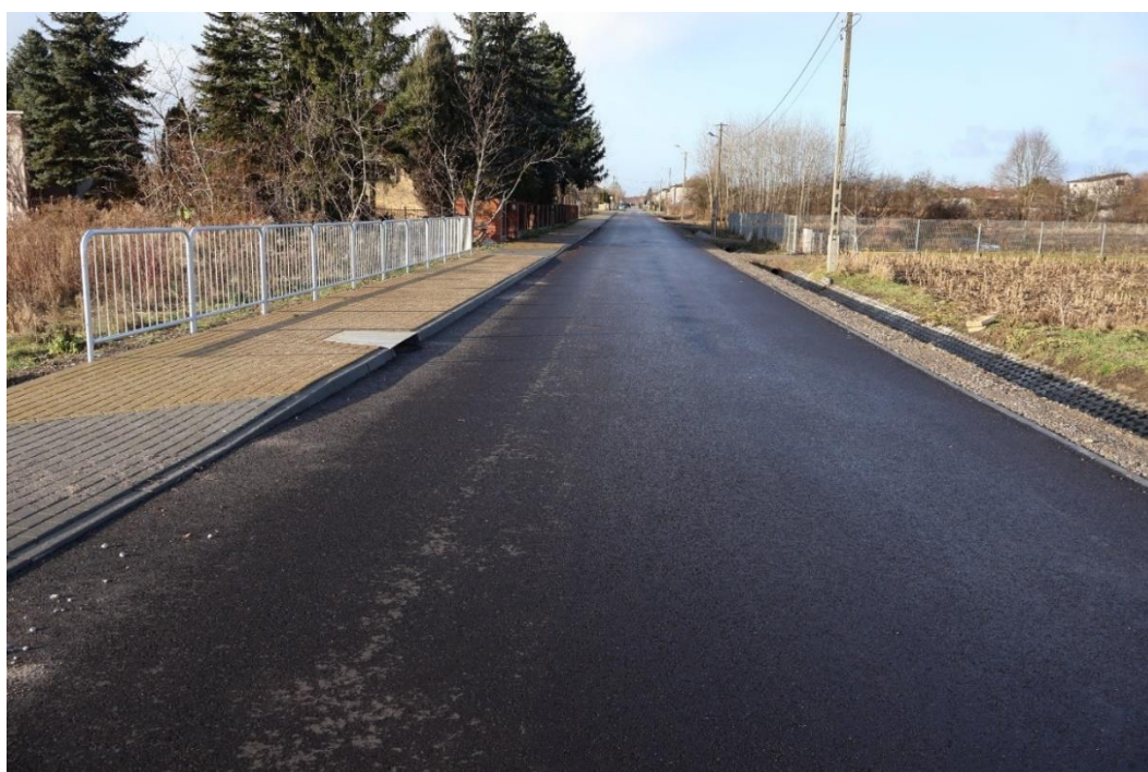
Przebudowa ul. Granicznej
