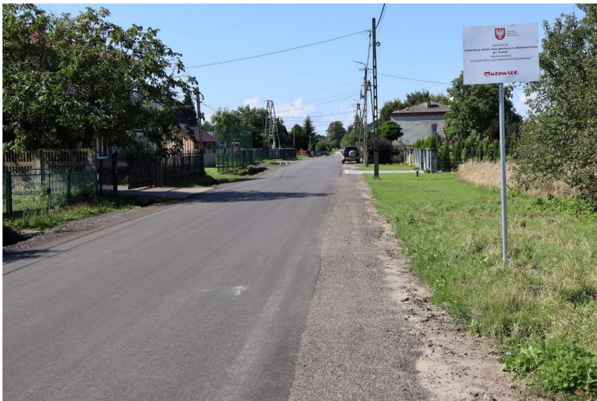
Przebudowana droga w miejscowości Strykowice Górne
