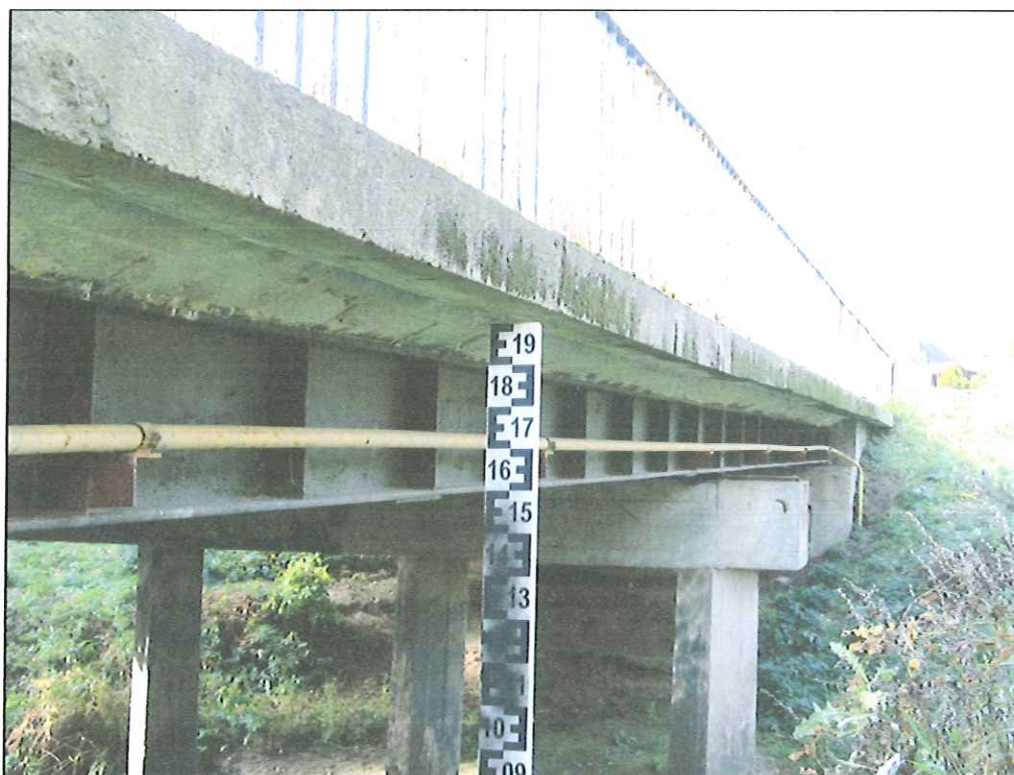
Fot. 4. Bok ustroju nośnego po stronie dolnej wody (DW). Na pierwszym planie filar od strony drogi krajowej DK nr 9.
