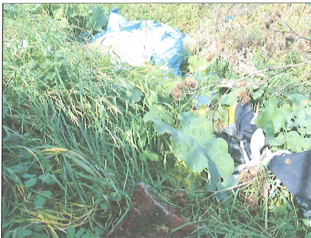
Fot. 6. Wysypisko śmieci po stronie m. Szewna – dolnej wody (DW). Nadmierna wegetacja roślinności. Brak bieżącego utrzymania obiektu.
