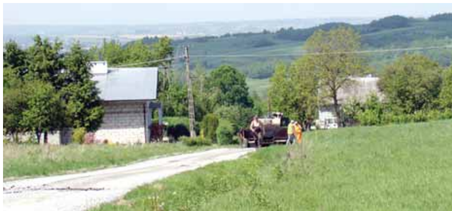
Przebudowa drogi gminnej Lubenia-Doły
