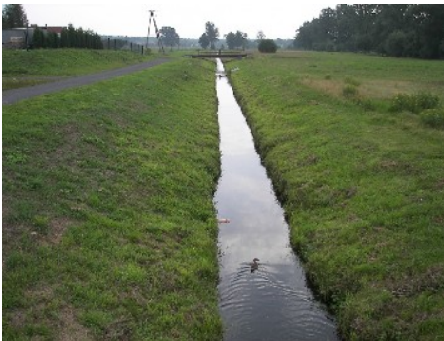
Zdjęcie nr 6 Koryto rzeki Korzeniec – widok w kierunku wschodnim za oczyszczalnią ścieków
