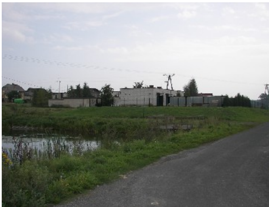
Zdjęcie nr 4 Oczyszczalnia ścieków „Wschód”
