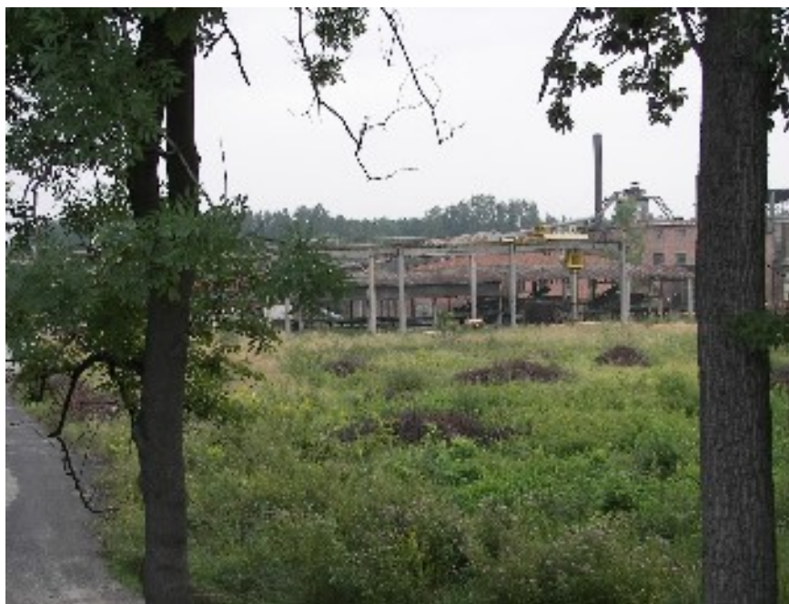
Zdjęcie nr 8 Widok na teren nieistniejących Zakładów Drzewnych „TiS” w Kobiórze
