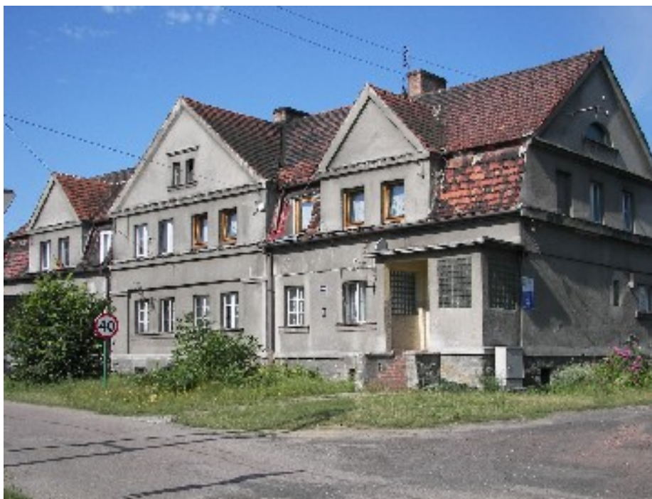
Zdjęcie nr 2 Budynek mieszkalny dwukondygnacyjny, na planie prostokąta, dach mansardowy z trzema lukarnami. 1920-1930r ul.Orla 4
