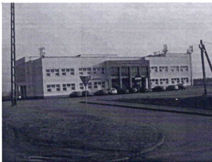
Zał. nr 1: Widok ogólny instalacji radiokomunikacyjnej.
